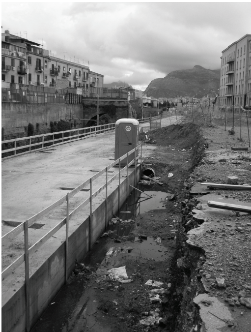
Costruzione del solaio di copertura del tracciato ferroviario sotterraneo
