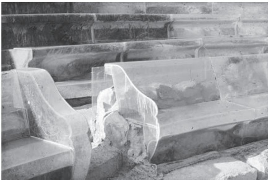
Fig. 10. Eraclea Minoa, porzione del teatro simile alla precedente in cui si può notare l'ingiallimento del *perspex*, la vegetazione infestante e il disfacimento del materiale lapideo. Nella parte in cui l'involucro di laminato plastico è stato asportato, è possibile anche osservare qualche brandello della sottile crosta formatasi con l'impiego dei materiali chimici consolidanti e protettivi (foto F. Tomaselli 1979).
