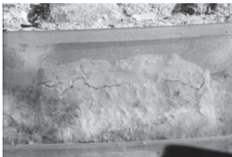
Fig. 11. Eraclea Minoa, dettaglio dello schienale della *proedria* in cui si può notare il forte ingiallimento delle lastre di perspex e la fratturazione della crosta formata dai rimedi chimici consolidanti (foto F. Tomaselli 1979).
