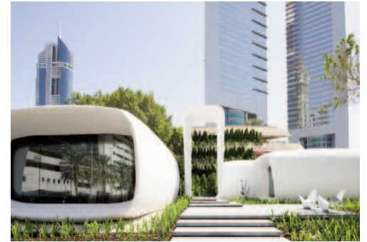
Fig. 29 - Il primo ufficio realizzato a Dubai nel 2016 con stampa 3D e tecnologia additiva: i componenti di base, prodotti con una miscela di cemento speciale (armato), fibra di vetro e plastica rinforzata con fibre, sono stampati in stabilimento e poi assemblati in cantiere (© WinSun, 2016).
