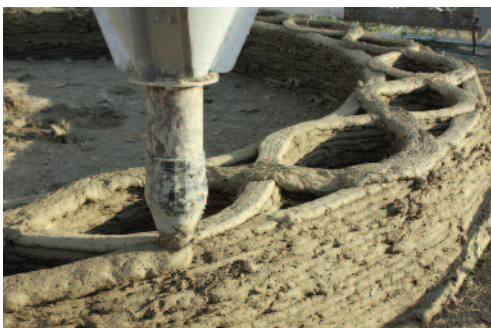
Figg. 33, 34 - La presentazione della BigDelta a Massa Lombarda (RA) nel 2015 e la stampa dimostrativa di un volume circolare: altezza e diametro del manufatto rispettivamente m 2,70 e 5,140 di materiale distribuito su 135 layer, m 3 2 d'acqua e 200 Kwh di energia consumati (© WASP Team).
