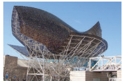
Fig. 9 - Il Peix d'Or realizzato con pannelli in acciaio color bronzo, sul waterfront di Barcellona (Gehry, 1992).
