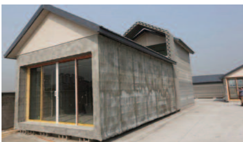
Fig. 23-25 - L'unità residenziale prodotta dalla WinSun e alcuni particolari della struttura: l'azienda cinese stampa in 3D separatamente i componenti di base e poi li assembla in situ (© WinSun, Pechino 2014).
