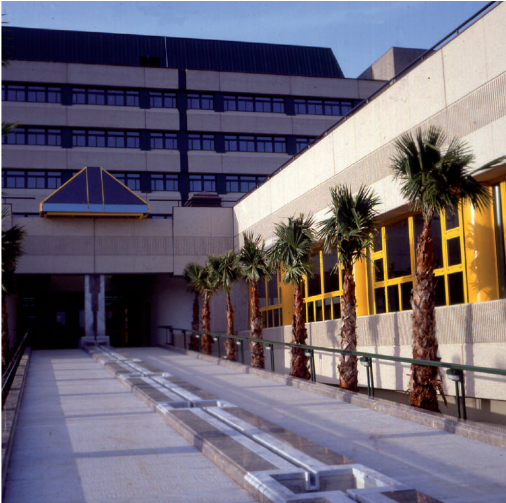
Fig. 13 - Il Nuovo Palazzo delle Finanze: veduta della rampa d'accesso con la fontana (1988).
