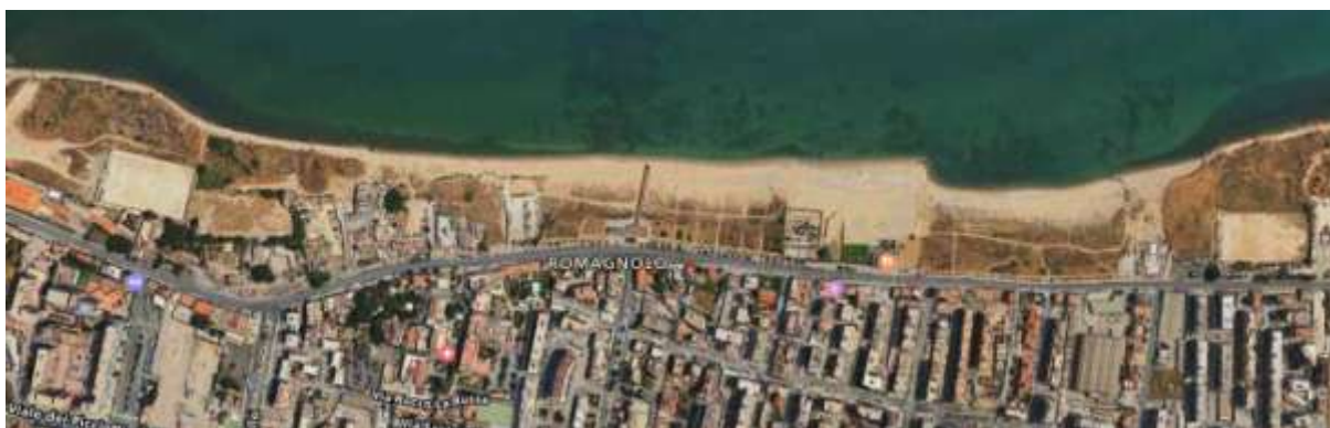
Figura 6. Litorale e urbanizzazione della Borgata di Romagnolo (Palermo)
