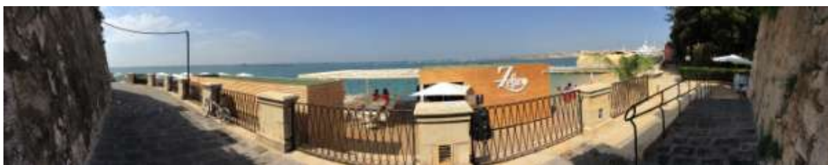
Figura 7. Panoramica dello “Stabilimento elioterapico” in Ortigia
