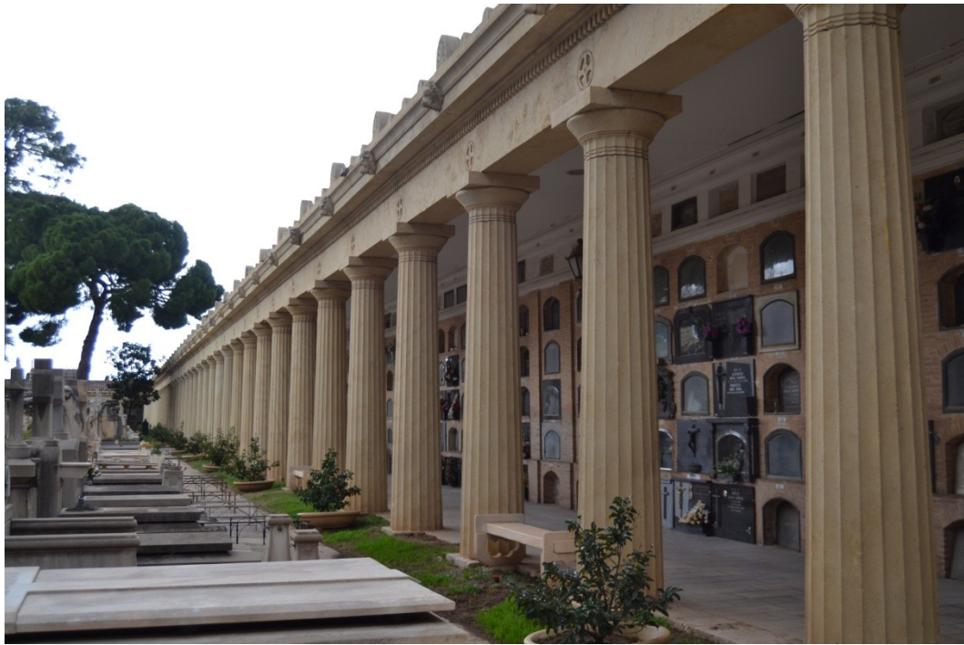
Fig. 4. Columnata Cementerio General. Fotografía: Inés Cabrera Sendra.
