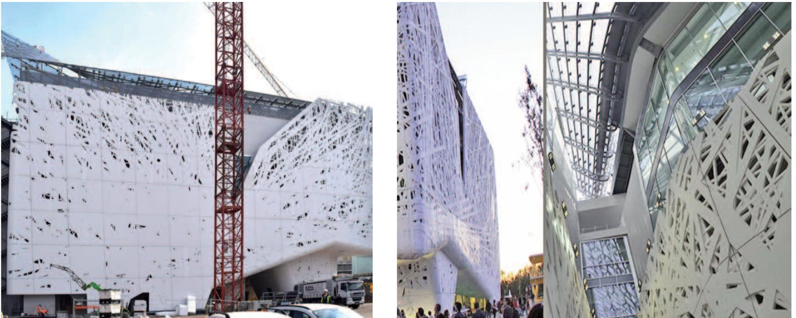
Fig. 3, 4 - Montaggio dei pannelli di cemento biodinamico i.active Biodynamic nel Padiglione Italia a Milano (Expo 2015).
