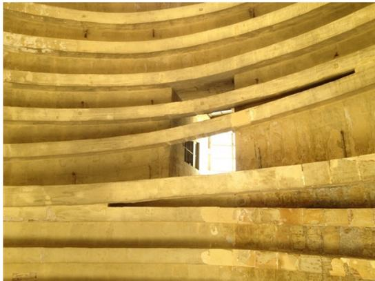
Figura 131 Volta costolonata con apertura
