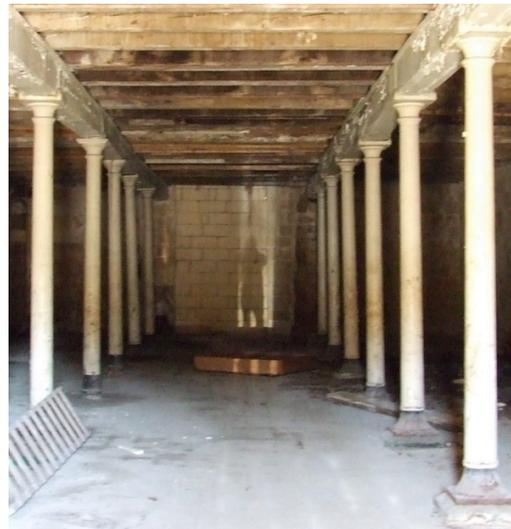
Figura 125 Colonne in ghisa all'interno del Naval Bakery - a sx - e all'interno dei magazzini della banchina ovest
