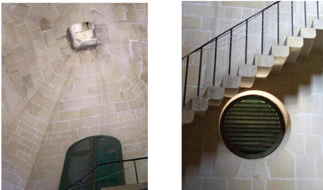
Figura 124 Volta torretta del Naval Bakery, scala e taglio dei blocchi attorno ad apertura circolare. Foto C. Thake
