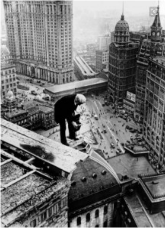
La costruzione del Woolworth tra cielo e terra
