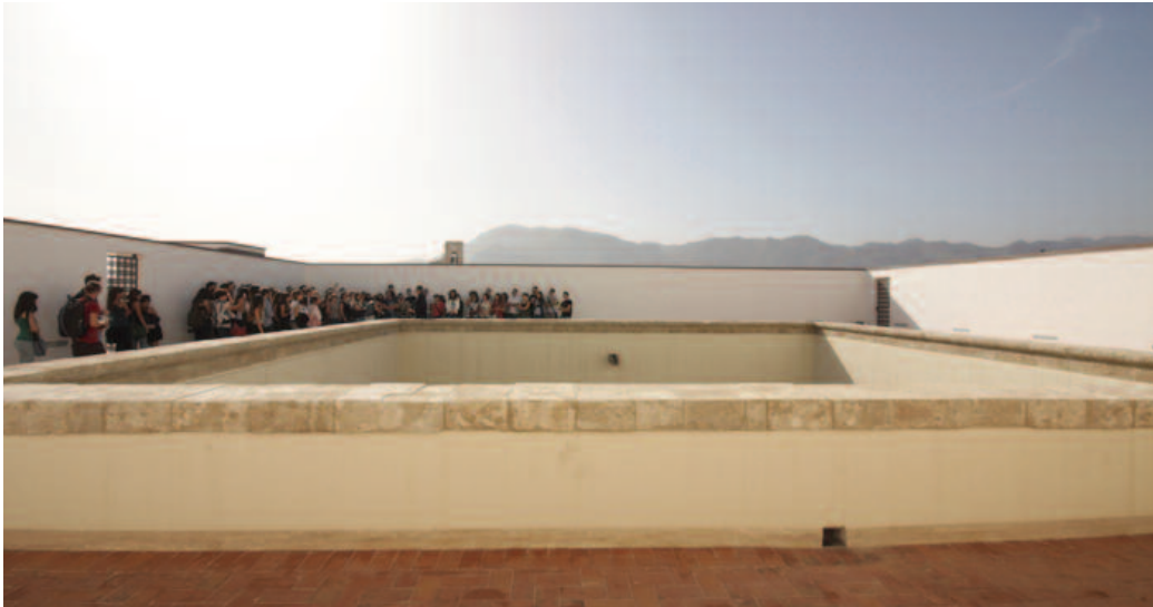
Fig. 18 - Dalla terrazza esterna alla Sala delle Capriate il recinto all'ultimo livello dello Steri (Ph. Greg Taig).
