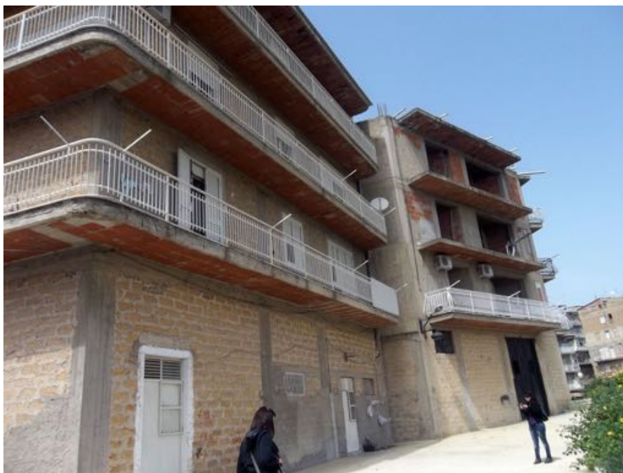
Figura 3 | Abusivismo edilizio a Favara. Fonte: foto dell'autore.
