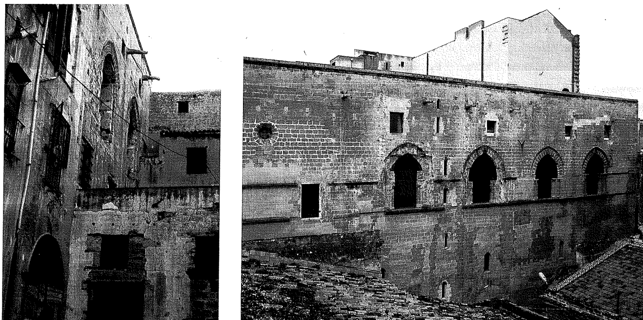
Figg. 3-4. Il fronte est prima e dopo l'intervento di restauro (da Lo Steri di Palermo... , a cura di A. I. Lima, 2006).
