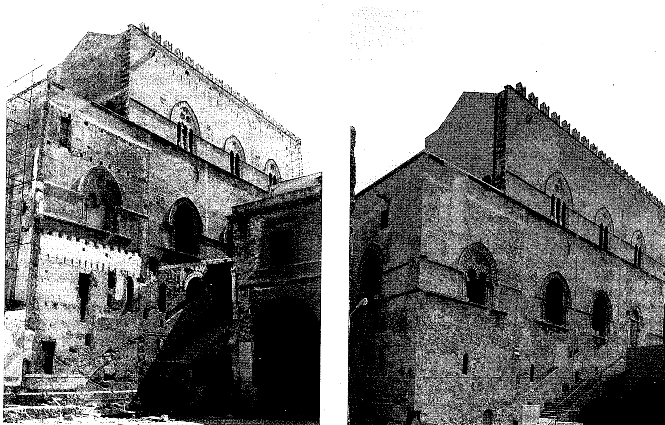
Figg. 5-6. Il fronte nord durante e dopo i lavori di restauro (da Lo Steri di Palermo... , a cura di A. I. Lima, 2006).
