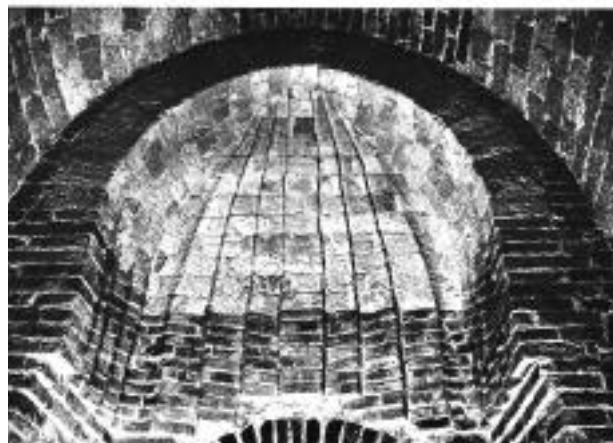
46-47. Caronia. Castello, pianta e sezione della sala triloba e dettaglio della copertura, (da W. Kronig, Il Castello di Caronia in Sicilia... , cit., p. 64)..
