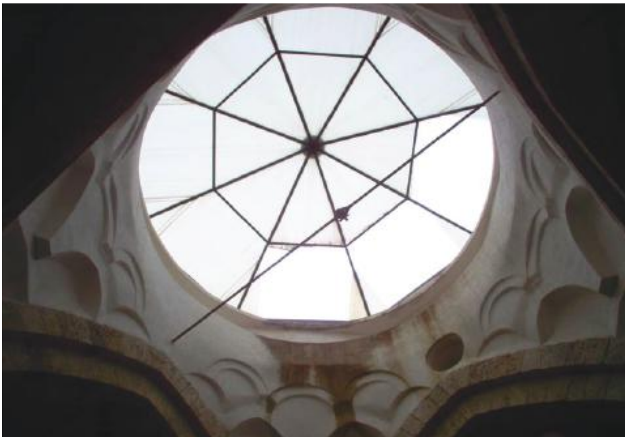
53. Messina. Santa Maria della Valle (Badiazza), veduta dell'imposta della cupola.
