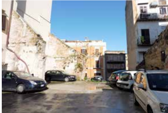
Veduta interna dell'area due verso via dei Candelai.
