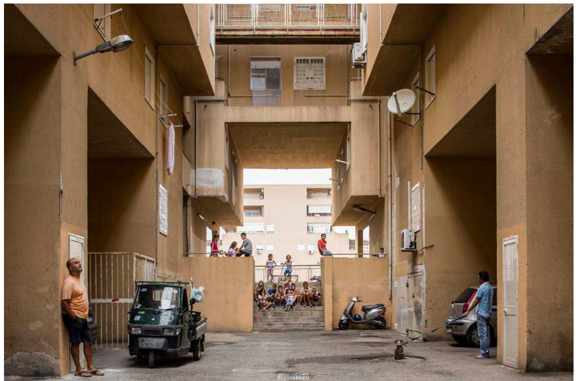
10 - La strada carrabile al centro dell'Insula.
