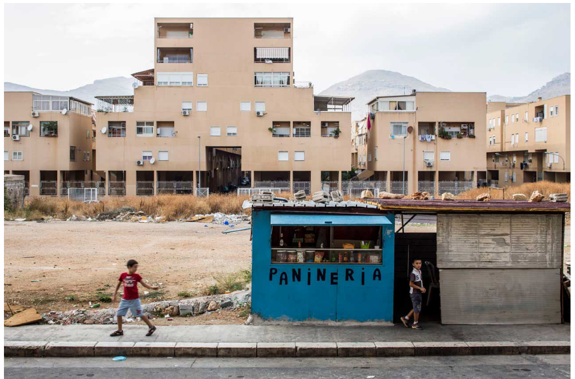
9 - Il grande slargo destinato all'asse dei servizi, mai realizzati. Vista da via Antonino Cannatella.
