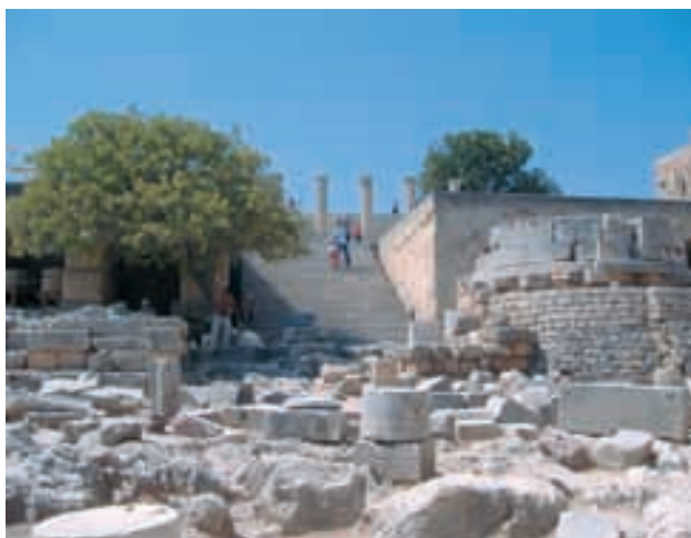
Fig. 19 - Lindos, Acropoli, accesso attraverso il castello cavalleresco, 2006. I lavori nel castello e nell'acropoli furono ripresi dallo Jacopi nel 1924 la collaborazione del colonnello Fusoni
