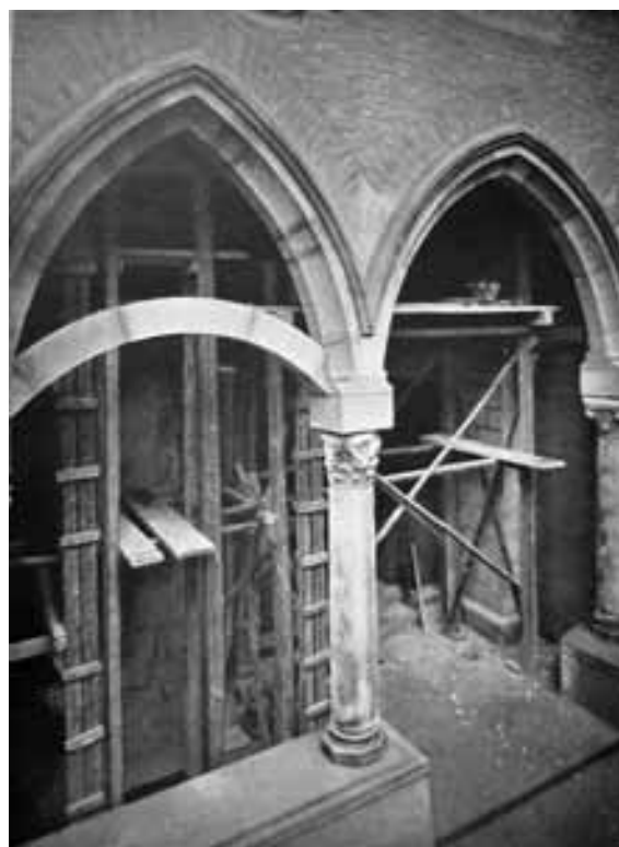
Fig. 39-40 Napoli, Chiesa dell'Incoronata, Portico esterno durante il consolidamento di una colonna, Liberazione delle prime arcate del portico, CHIERICI G., Restauro della Chiesa dell'Incoronata a Napoli , 1930, p. 422 -423
