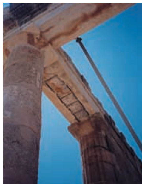
Fig. 3 - Lindos, Acropoli, Propilei, vista sul lato est della scalinata, 2005. Si nota il sistema di puntellamento dell'architrave prima della loro eliminazione avvenuta nel corso dei recenti interventi di restauro. Gli elementi d'integrazione dell'architrave erano stati realizzati in calcestruzzo di cemento armato, ricoperto da uno strato di intonaco di calce intonato e distinguibile dai conci superstiti e rimontati
