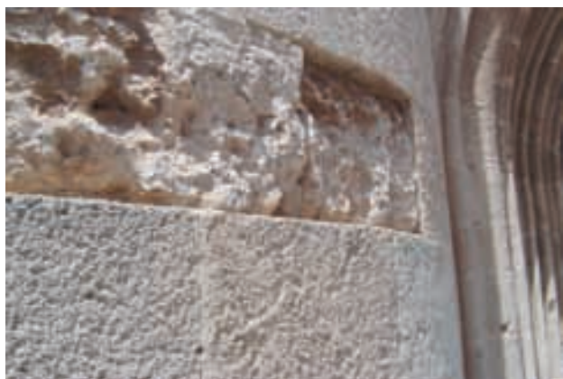
Fig. 174 - Rodi, palazzo del Gran Maestro, torre sinistra del portale di accesso al palazzo, particolare dei conci della muratura, 2006. Si nota la conservazione di pochi conci ammalorati della torre posta a sinistra rispetto all'accesso del palazzo, la rimanente parte è stata completamente rifatta con il sistema dell'“impellicciatura”
