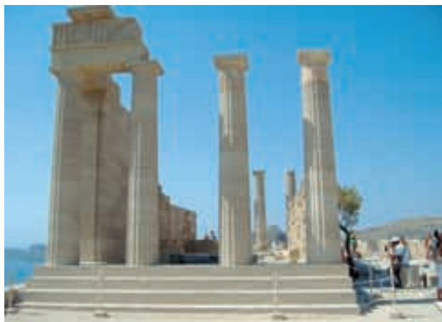
Fig. 22 - Lindos, Acropoli, particolare di una delle colonne dei Propilei dell'acropoli e del basamento fronte ovest, 2006. Si nota che nei restauri realizzati recentemente è stato utilizzato lo stesso materiali e sono state ricreate le forme primitive. L'effetto finale è davvero disorientante e privo di fondamento scientifico
