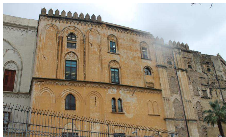
Figg. 49-50. Prospetto sud-occidentale in corrispondenza dell'ingresso al palazzo.
