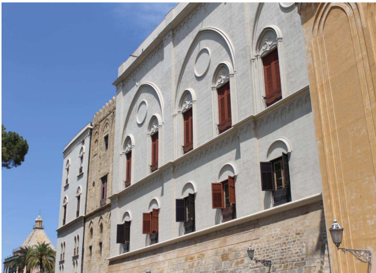
Fig. 53-54. Prospetto occidentale in due foto attuali.
