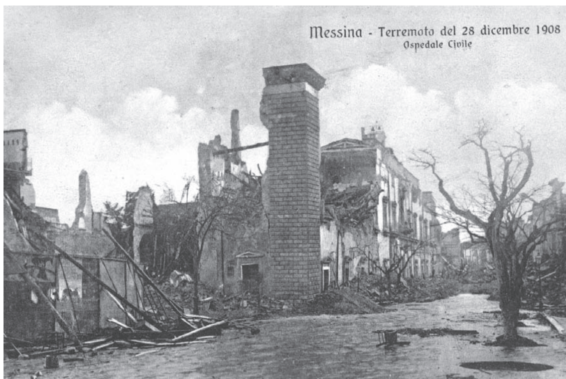
Messina. Terremoto del 28 dicembre 1908. Ospedale Civile.
