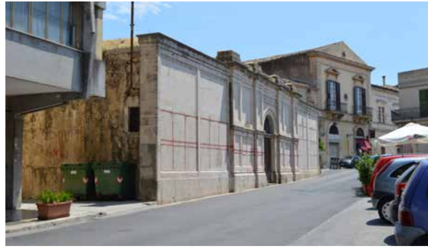
16. Il Serbatoio Idrico.
