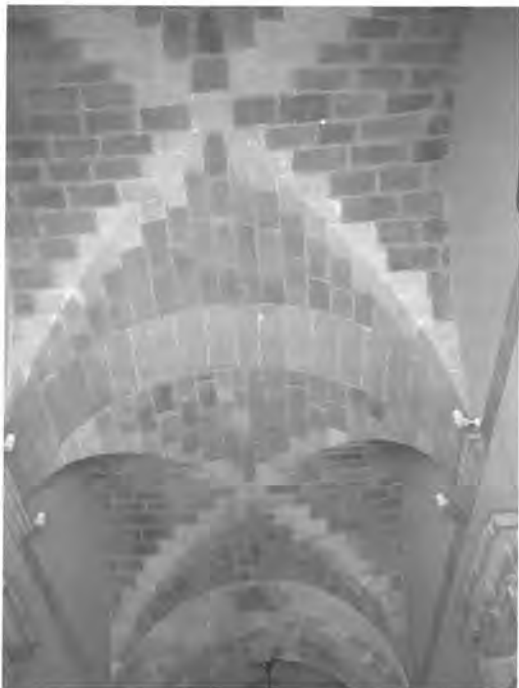
Figure 3 Siracusa, Palazzo Comunale, volte sull'atrio; chiostro dei Cappuccini, volte; Ragusa, ricostruzione delle volte sul chiostro dei Cappuccini; Scicli, convento di Sant'Antonino, volta della Sagrestia (archivio Cosmed)
