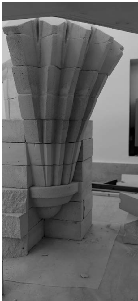
16. Posa in opera del tas-de-charge .
