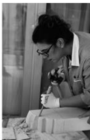
13-15. A sinistra, collegamento della sezione superiore e inferiore di alcuni elementi del tas-de-charge , al centro, definizione delle superfici a vista di un elemento del tas-de-charge ; a destra, i quattro filari n. 6 dei tas-de-charge pronti per la posa in opera.
