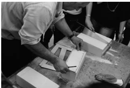
7. Tracciamento della faccia laterale del concio.
