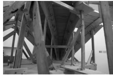
18-20. A sinistra, fissaggio dei piedritti di sostegno e posa in opera delle centine degli archi; al centro, posa in opera dei primi concetti dei costoloni; a destra, posa in opera delle vele.
