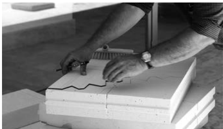
12. Sagome e tracciamento dei filari del tas-de-charge .
