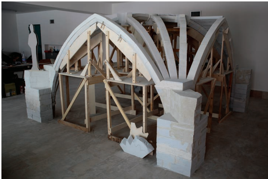
1. La volta al termine delle operazioni di montaggio.
