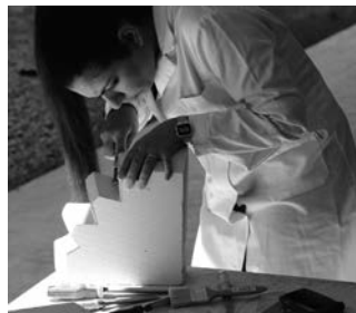
13-15. A sinistra, collegamento della sezione superiore e inferiore di alcuni elementi del tas-de-charge , al centro, definizione delle superfici a vista di un elemento del tas-de-charge ; a destra, i quattro filari n. 6 dei tas-de-charge pronti per la posa in opera.
