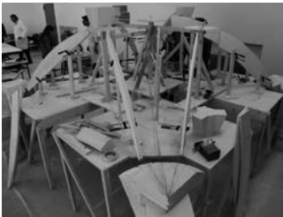
18-20. A sinistra, fissaggio dei piedritti di sostegno e posa in opera delle centine degli archi; al centro, posa in opera dei primi concetti dei costoloni; a destra, posa in opera delle vele.
