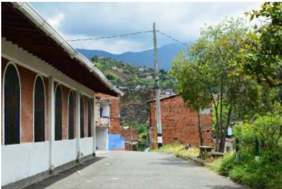
89*. Prospetto laterale della Chiesa di San Vicente Ferrer.
