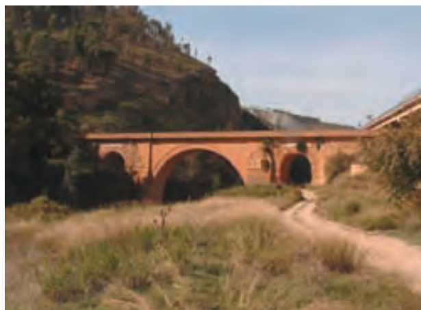
Fig. 3 - Termini Imerese, Ponte sul Fiume San Leonardo, progettato da Agatino Daidone e completato nel 1723
