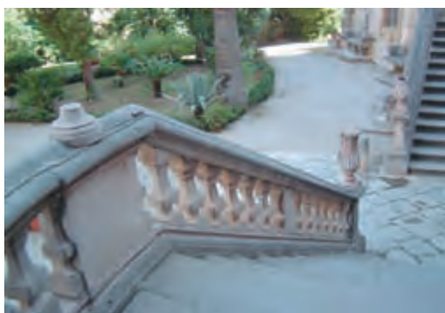
Fig. 5 - Bagheria, Villa Palagonia, emiciclo orientale, particolare degli intonaci presenti nei prospetti dei corpi bassi della villa
