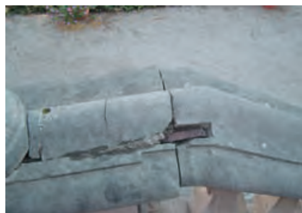
Fig. 7-8 - Bagheria, Villa Palagonia, corpo centrale di fabbrica, prospetto settentrionale, rampa destra dello scalone d'onore, particolare del sistema di fissaggio dei blocchi lapidei mediante la collocazione di placche di ferro annegate in colate di piombo e ricoperte da uno strato di malta di pozzolana e polvere del materiale costituente lo scalone
