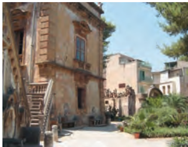
Fig. 2 - Bagheria, Villa Palagonia, corpo centrale di fabbrica, angolo lato sud-ovest
