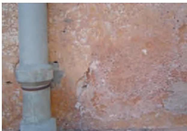
Fig. 1 - Bagheria, Villa Palagonia, corpo centrale di fabbrica, bastione nord-ovest, prospetto occidentale
