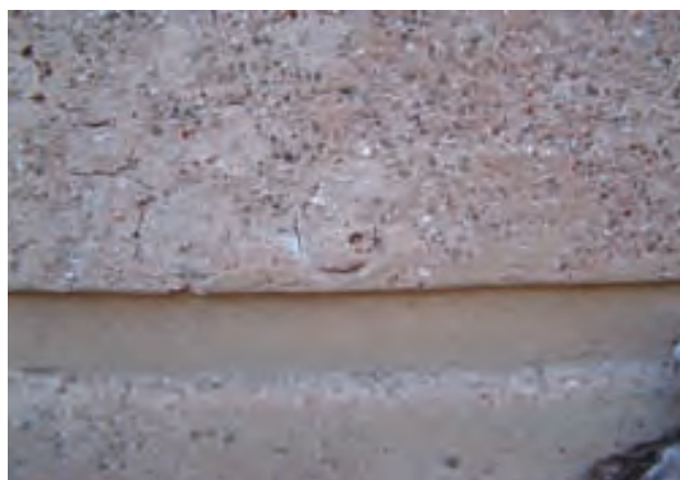
Fig. 3 - Bagheria, Villa Palagonia, corpo centrale di fabbrica, prospetto settentrionale, lesene ad incantonato
