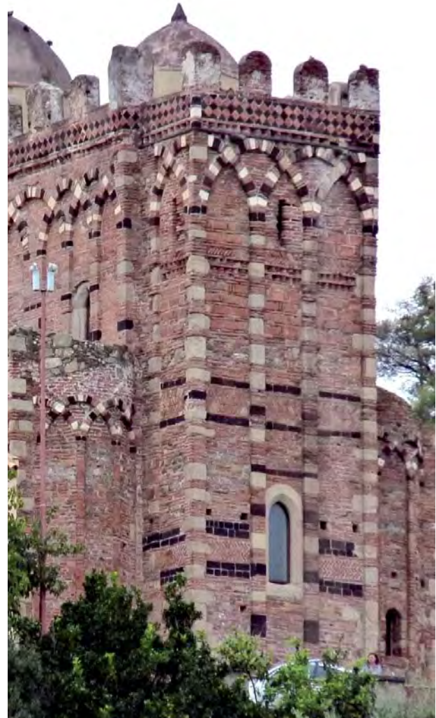
3. Casalvecchio Siculo. Chiesa dei Santi Pietro e Paolo, vista esterna delle absidi.
