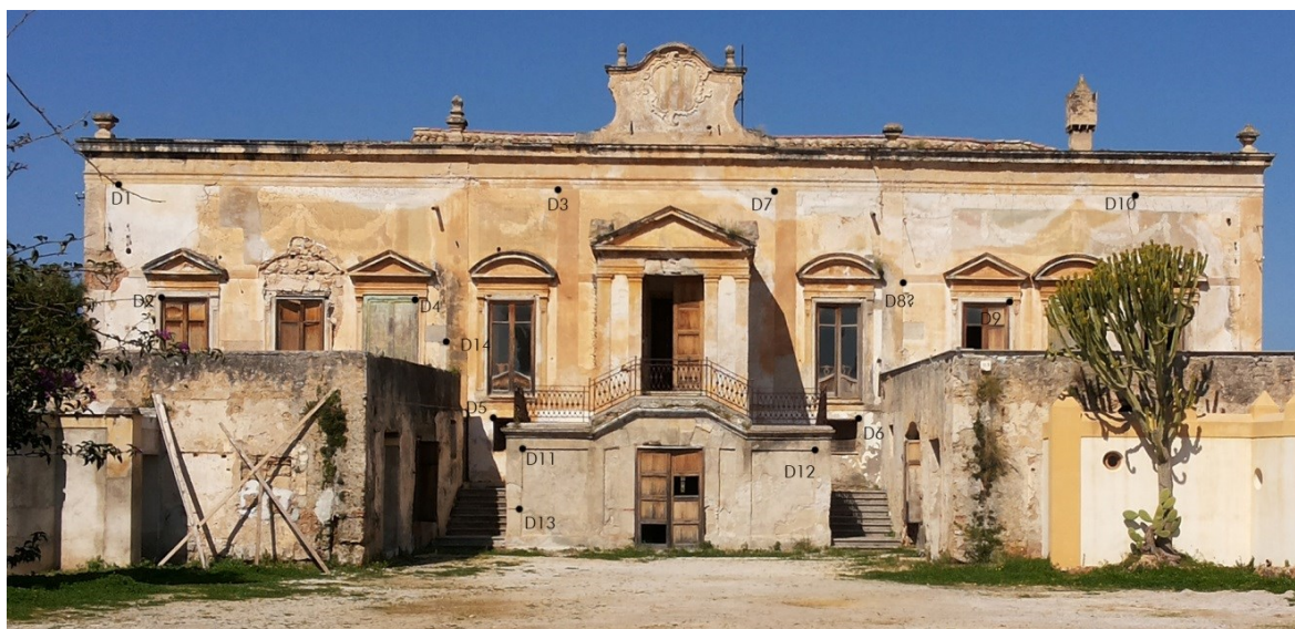
Figura 115. Punti di appoggio: esempio sul prospetto principale
