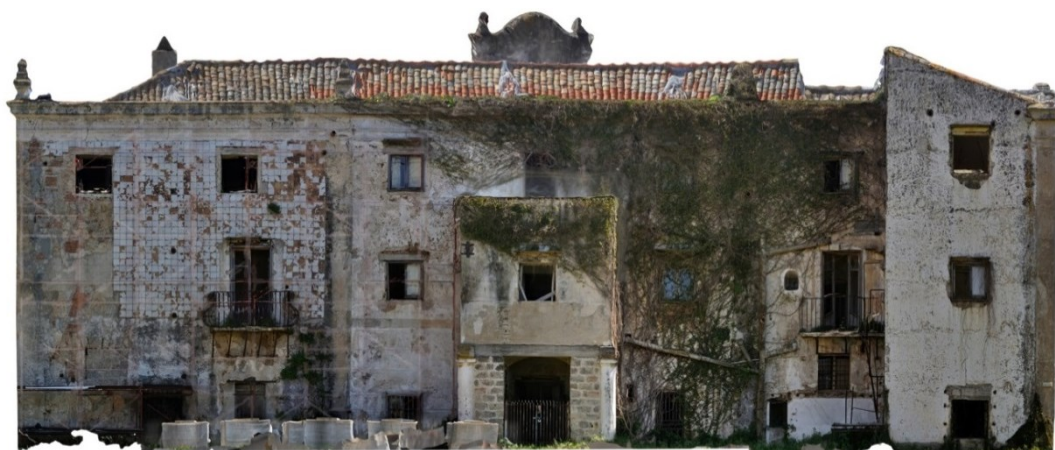
Figura 125. Ortofoto del prospetto Sud-Est
