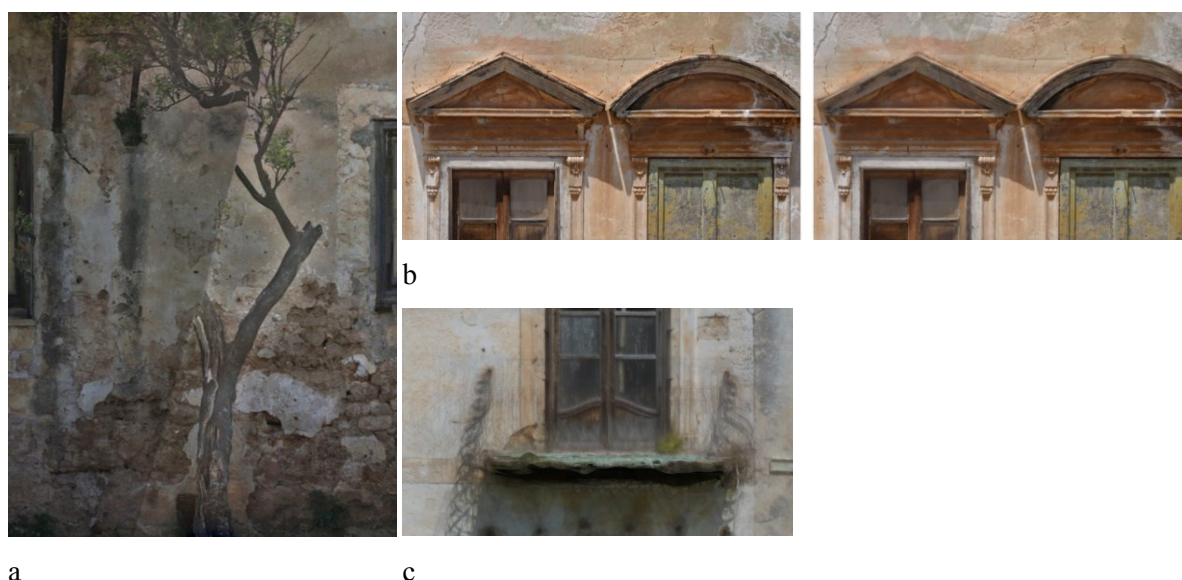
Figura 129. Particolare dell'unione tra due immagini successive (a); influenza degli ostacoli sull'intensità radiometrica (b); proiezione degli ostacoli sull'ortofoto (c).
