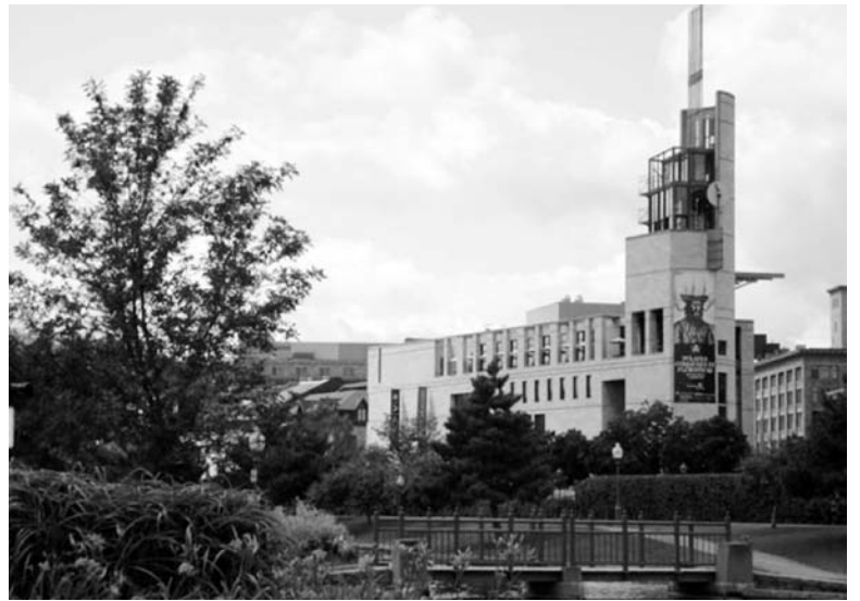
L'edificio dell'Éperon, che rappresenta l'ingresso a Pointe-à-Callière, costruito sulle rovine della Royal Insurance Tower.
