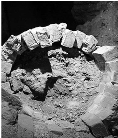
Collettore fognario in mattoni di sec. XIX, che attraversa le fondazioni di una fortificazione francese di sec. XVIII.
