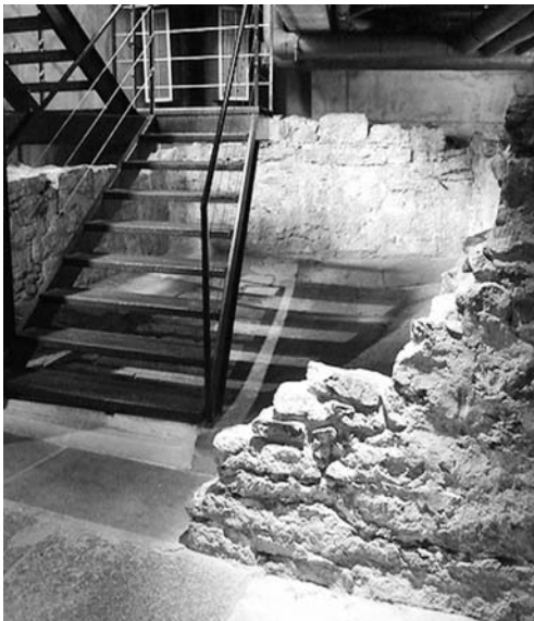
Scorcio dell'itinerario sotterraneo.
