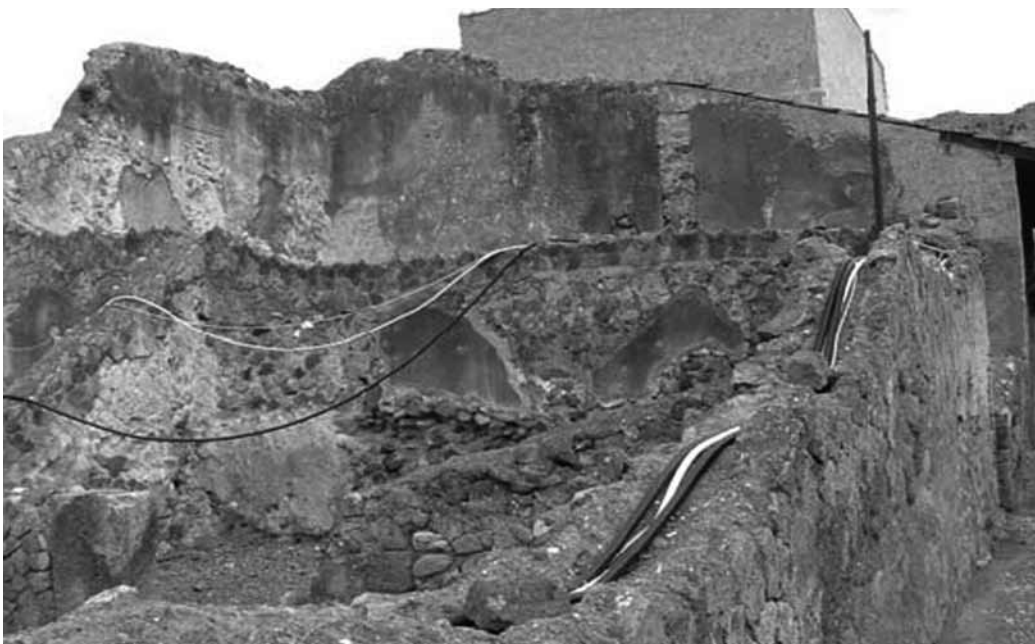
Fig. 11- Pompei, il passaggio dei cavi sulle creste murarie.
