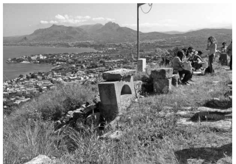
Figg. 3, 4 - Solunto: obsoleto sistema d'illuminazione artificiale, risalente agli anni Settanta, consistente in blocchi di calcestruzzo in cui venivano alloggiate lampade a incandescenza.
