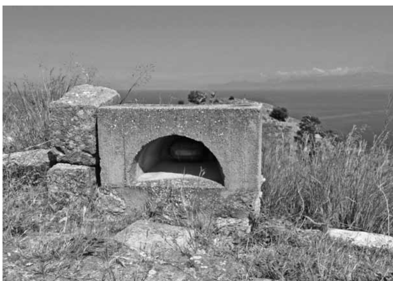
Figg. 3, 4 - Solunto: obsoleto sistema d'illuminazione artificiale, risalente agli anni Settanta, consistente in blocchi di calcestruzzo in cui venivano alloggiate lampade a incandescenza.
