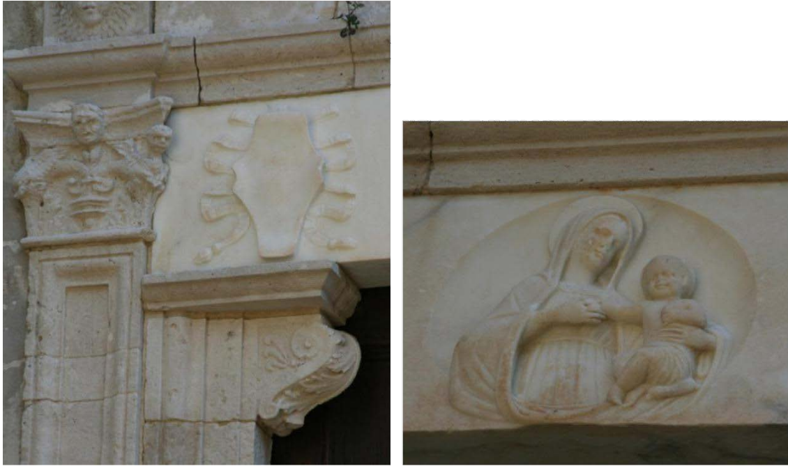
Fig. 16 Portale principale particolari
