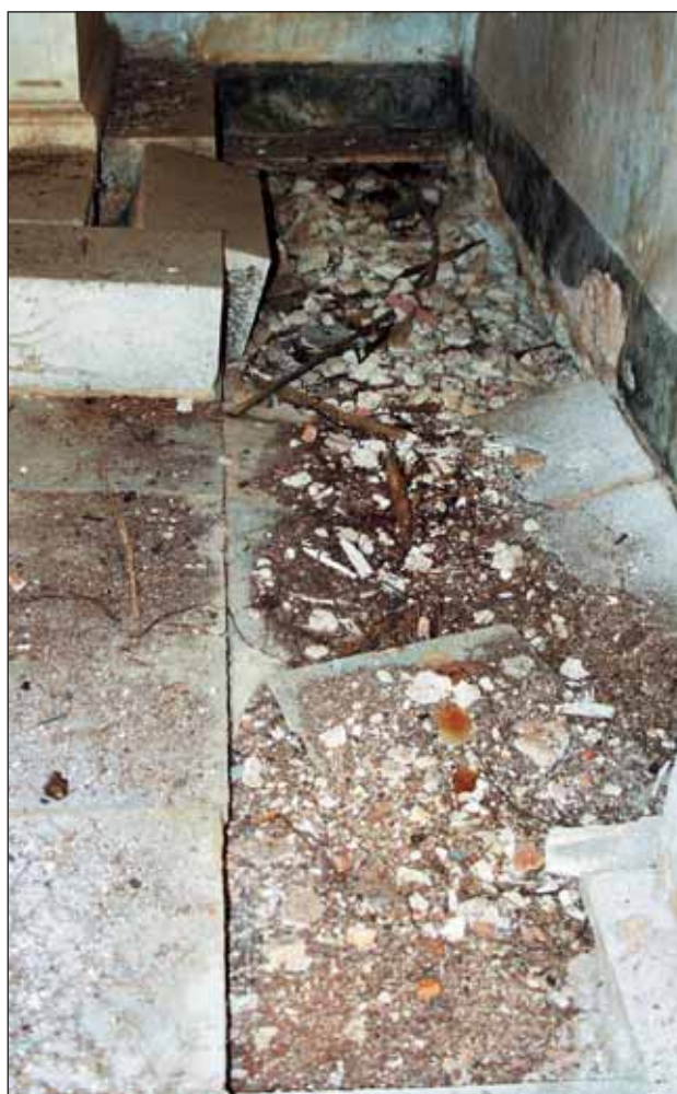
Fig. 16 – Monumento Gravina Bonanno, 1855, cimitero di Sant’Orsola, Palermo, particolare della pavimentazione interna: appare evidente il pessimo stato di conservazione principalmente lungo la parete destra dovuto ai numerosi elementi dismessi.
