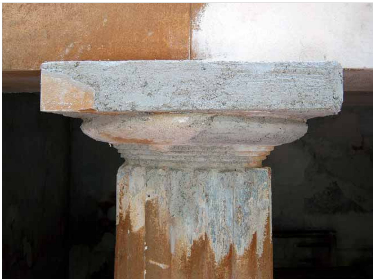
Fig. 30 – Monumento Gravina Bonanno, 1855, cimitero di Sant’Orsola, Palermo, stuccatura delle mancanze e delle lacune di profondità tramite malta inorganica simile per composizione, granulometria e colore ai materiali costitutivi dello strato di intonaco più interno.
