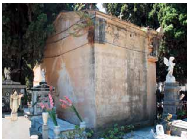
Fig. 19 – Monumento Gravina Bonanno, 1855, cimitero di Sant'Orsola, Palermo, particolare che mette in evidenza il degrado differenziale con un maggiore sviluppo di patine biologiche in corrispondenza delle zone più esposte.
