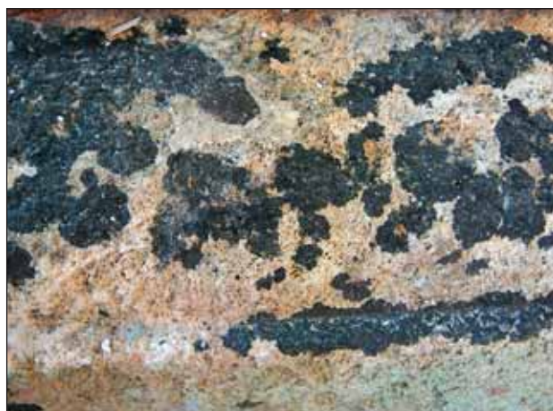
Fig. 15 – Monumento Gravina Bonanno, 1855, cimitero di Sant’Orsola, Palermo, licheni endolitici di tonalità scura relativi alla specie Verrucaria nigrescens Pers. al di sopra del muro perimetrale esterno.
