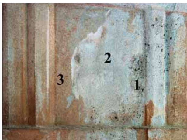
Fig. 5 – Monumento Gravina Bonanno, 1855, cimitero di Sant'Orsola, Palermo, particolare che mostra il rinzafo di colore grigio con inerti scuri (strato 1) e l' intonaco a granulometria più fine (strato 2) al di sotto della stesura di rifacimento di colore giallo chiaro (strato 3).
