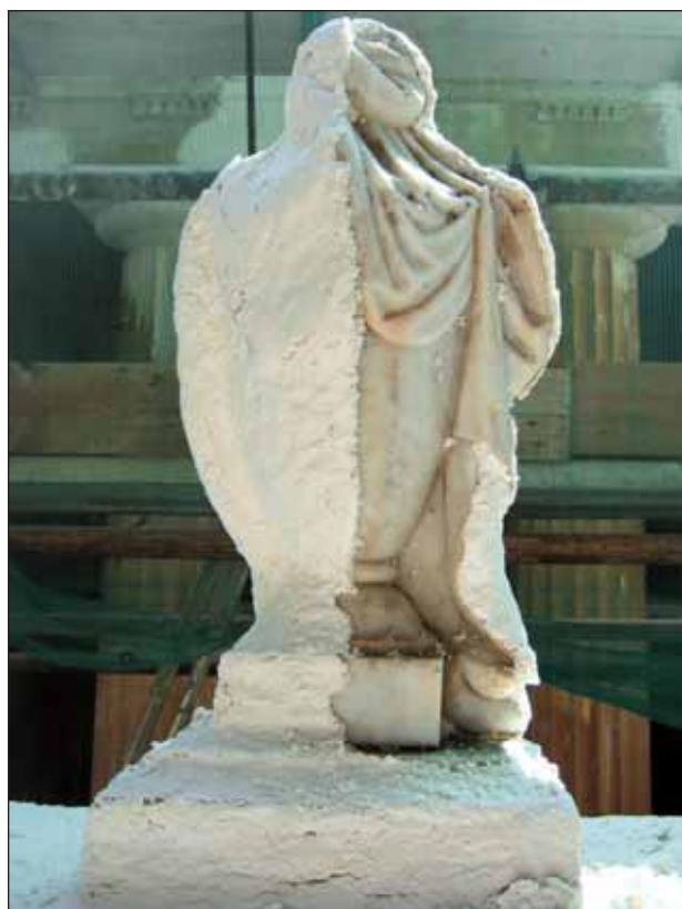
Fig. 33 – Monumento Gravina Bonanno, 1855, cimitero di Sant'Orsola, Palermo, particolare del monumento scolpito in marmo: il secondo livello di rifinitura è stato eseguito tramite impacchi di polpa di cellulosa ed una soluzione satura di acqua e carbonato di ammonio.
