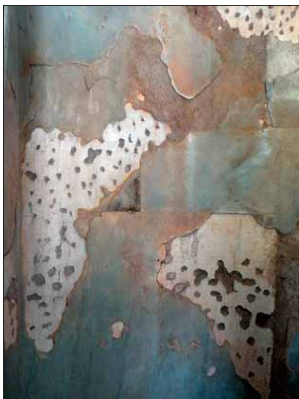
Fig. 7 – Monumento Gravina Bonanno, 1855, cimitero di Sant’Orsola, Palermo, dettaglio ripreso all’interno della cappella. L’immagine rende evidente lo strato di intonaco originale composto da una malta sottile, liscia e compatta (marmorino) anche se molto degradata, con numerose tracce di picchettature.
