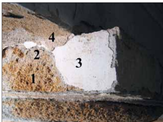
Fig. 6 – Monumento Gravina Bonanno, 1855, cimitero di Sant’Orsola, Palermo, particolare di un capitello che mostra la tecnica esecutiva delle colonne in successione stratigrafica: blocchi di roccia tufacea di colore giallo (strato 1); rinzaŕfo grigio a granulometria grossolana con inerti di tonalit  scura (strato 2); intonaco di colore bianco simile ad un rivestimento marmoreo (strato 3); stesura di rifacimento di colore giallo chiaro (strato 4).
