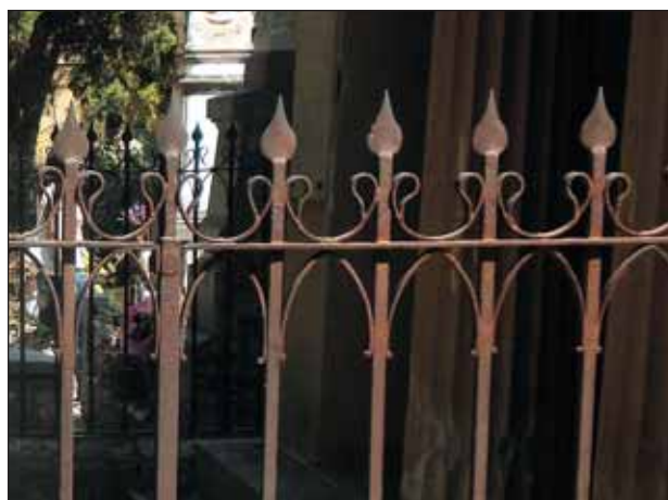
Fig. 10 – Monumento Gravina Bonanno, 1855, cimitero di Sant'Orsola, Palermo, particolare della recinzione metallica composta da assi verticali a terminazione lanceolata alle quali si alternano ulteriori elementi ricurvi a formare un modulo decorativo regolare e ripetuto.
