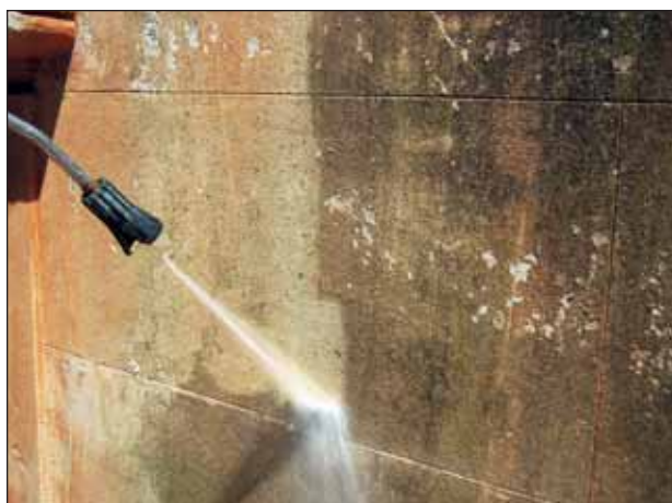
Fig. 29 – Monumento Gravina Bonanno, 1855, cimitero di Sant'Orsola, Palermo, rimozione delle patine algali da una delle pareti del monumento mediante idropulitrice.
