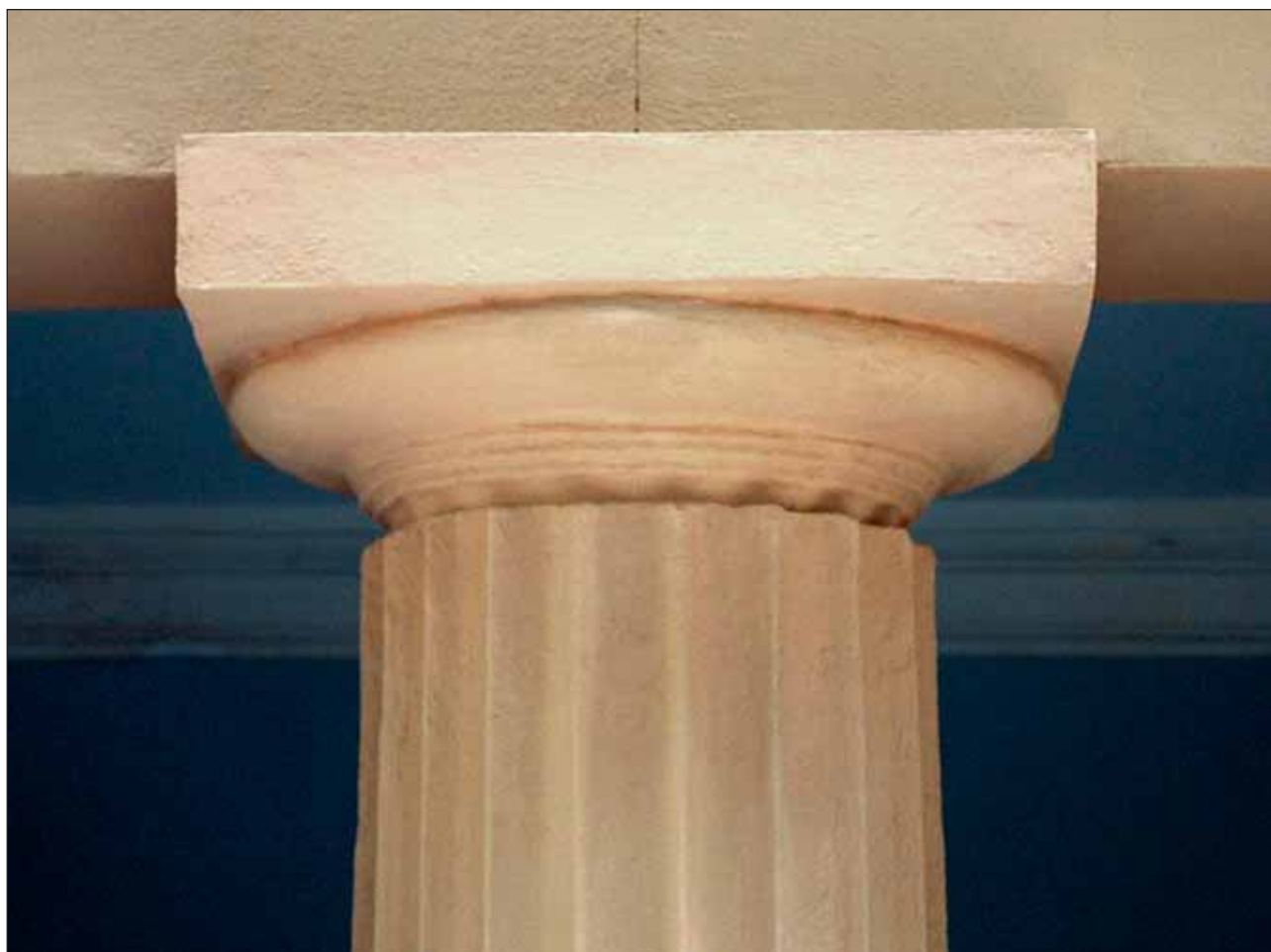
Fig. 31 – Monumento Gravina Bonanno, 1855, cimitero di Sant’Orsola, Palermo, stuccatura delle lacune più superficiali mediante impasto pigmentato a base di grassello di calce.
