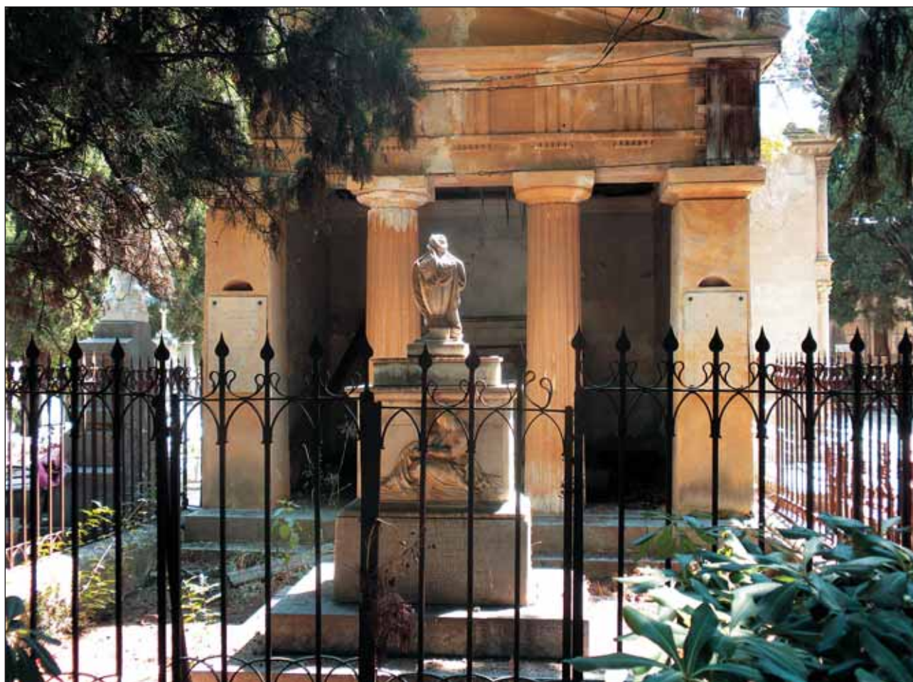
Fig. 2 – Monumento Gravina Bonanno, 1855, cimitero di Sant’Orsola, Palermo, prima dell’intervento di restauro.
