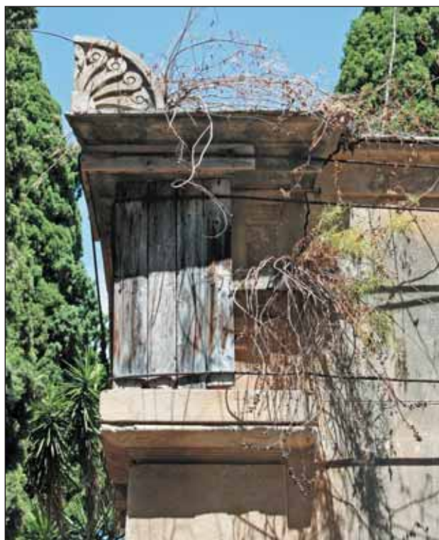
Fig. 12 – Monumento Gravina Bonanno, 1855, cimitero di Sant'Orsola, Palermo, particolare di uno degli angoli superiori interessato dalla presenza di piante infestanti.
