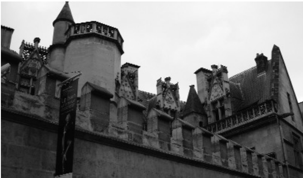
Muro merlato del fronte principale del Museo.
