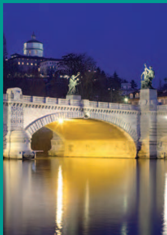
Ponte Umberto I a Torino
