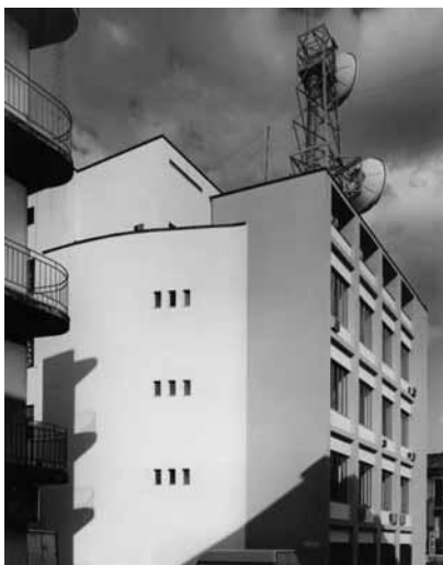
Messina. Centrale telefonica (V. Pantano, 1953), veduta esterna (foto A. Muciaccia).
