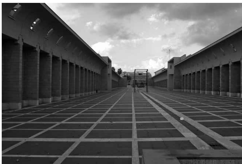
Gibellina Nuova. Sistema delle piazze (F. Purini, L. Thermes, 1981), realizzazione 1982-1990; veduta verso la composizione di spoglio di N. Vigo e verso il teatro di P. Consagra, 1984 e seguenti (foto P. Miceli, 2011).
