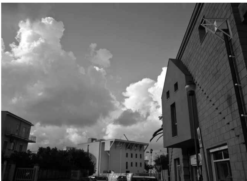
Gibellina Nuova. Casa del Farmacista (F. Purini, L. Thermes, 1981 e seguenti); veduta di scorcio del fronte principale; sul fondo Casa Pirrello di F. Purini e L. Thermes, 1988-1989, realizzazione 1990 e seguenti (foto P. Miceli, 2011).
