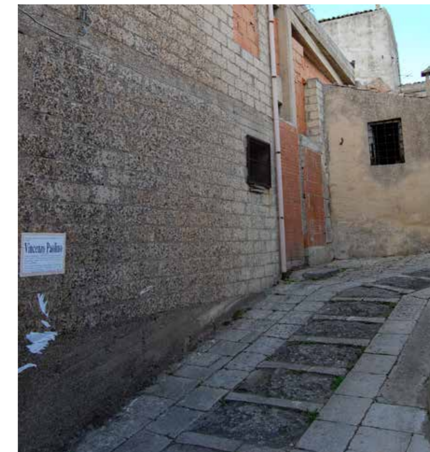
10a. - b. Sistemi costruttivi a confronto nel centro storico di Modica. A destra, immagine di un intervento edilizio incompiuto, in cui è evidente la struttura intelaiata in cls.a. e da cui scaturisce la certezza di una scarsissima qualità anche energetica degli esiti prefigurabili (foto M.L.G. 2014).
