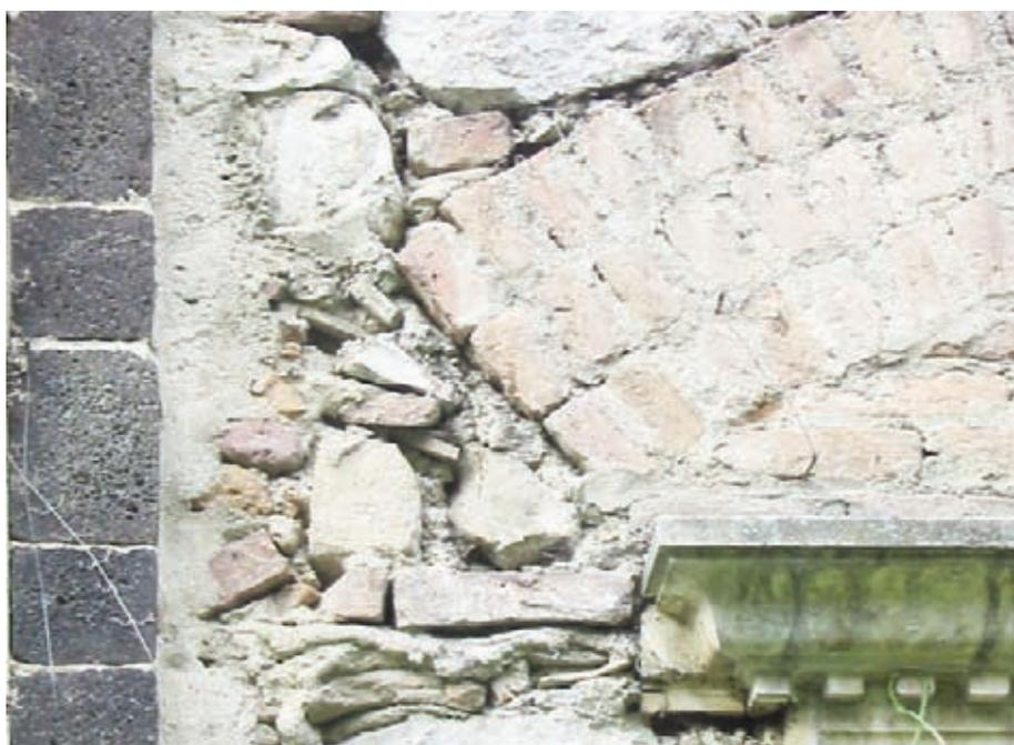
Figg. 11, 12 - Tessitura muraria in pietra di Taormina e mattoni; sotto, arco ribassato in corrispondenza delle aperture.
