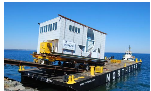
Fig. 15 La Casa Lieb si mette in viaggio in un barcone dalla costa del New Jersey al North Shore di Long Island. Durante il viaggio di due giorni, la casa ha navigato attraverso l'Oceano Atlantico.
