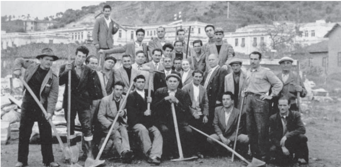
Fig. 3 - Maria Accascina durante i lavori del cantiere del Museo Nazionale di Messina.
