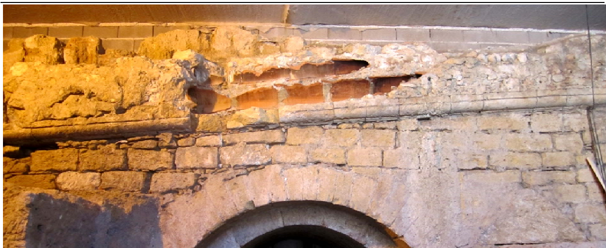
Figura 33: Cordone in lunghi blocchi in calcarenite, il cui andamento mostra l'originaria pendenza delle rampe.
