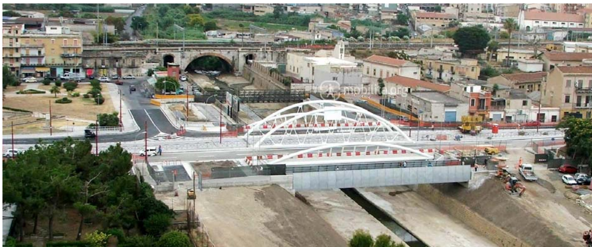
Figura 29: Il nuovo ponte bimodale in acciaio (quarto ponte delle Teste).
