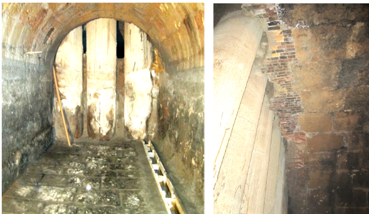
Figura 34: Il crollo parziale del parapetto mette in mostra cinque condotte d'acqua incassate al di sotto del paramento esterno.
