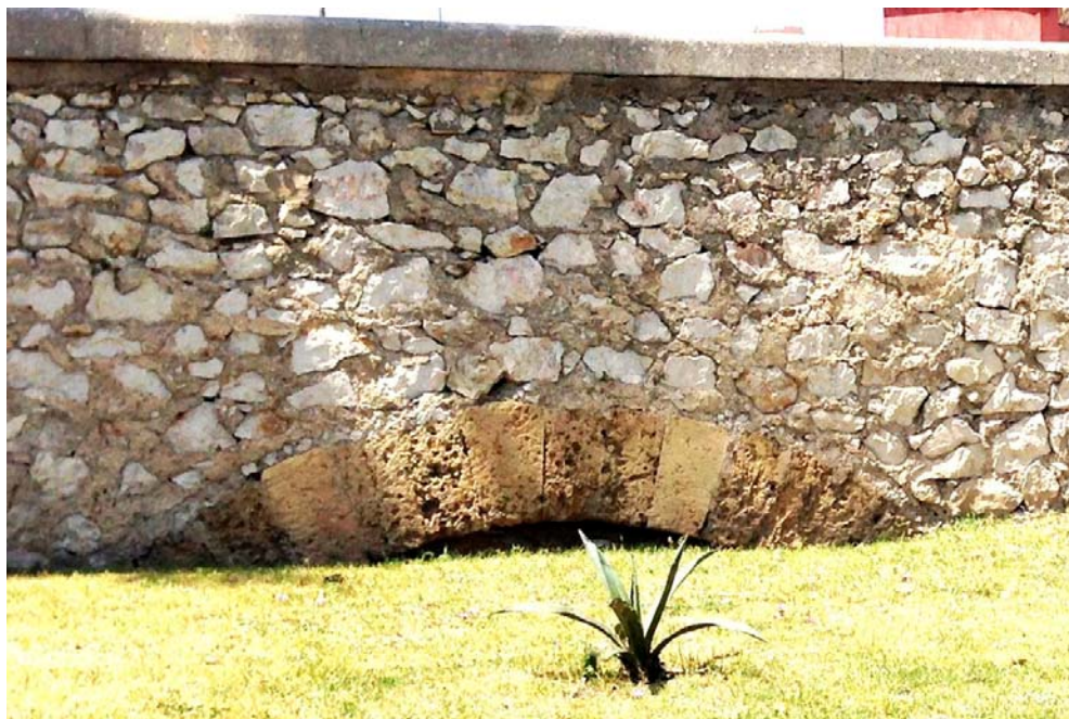
Figura 23: L'immagine fotografica mostra la faccia esterna della volta dell'originario ponticello sul "canale Battaglia", allargato rispetto alla precedente struttura di fine Settecento realizzata dal marchese Natale. La bocca del canale è stata tamponata in occasione della sistemazione a verde dell'intera area monumentale (anni '30).
