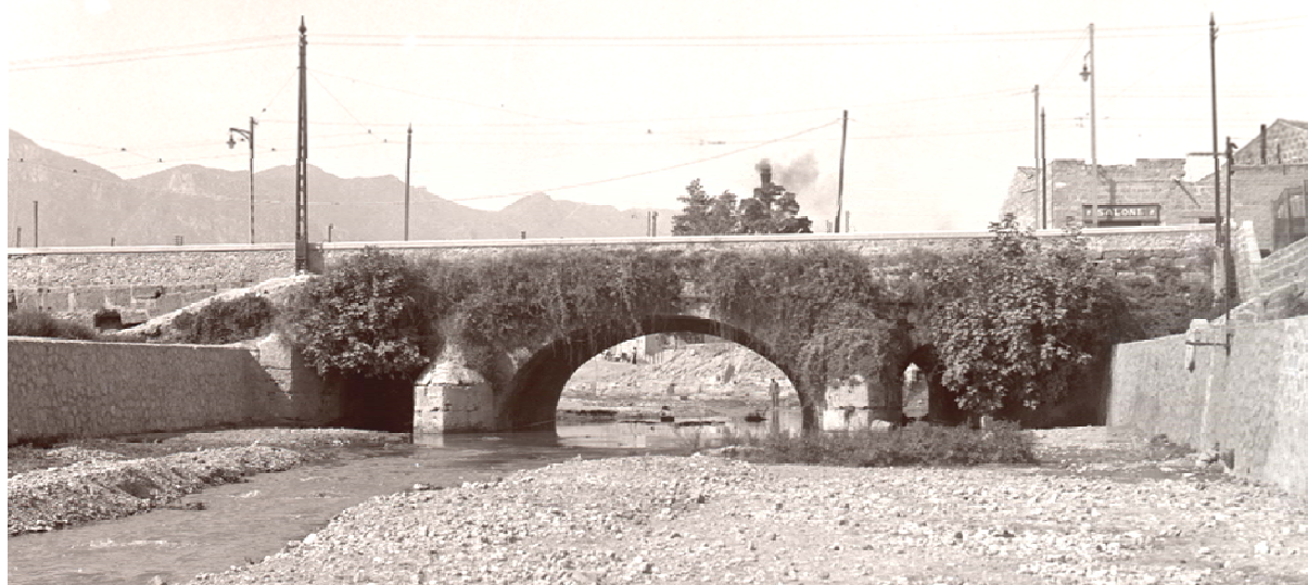
Figura 25: Foto del ponte delle Teste (lato valle) tratta dall'archivio Dante e Giuseppe Cappellani, databile ai mesi precedenti l'alluvione del 1931. La vegetazione infestante ostruiva gran parte delle campate laterali.
