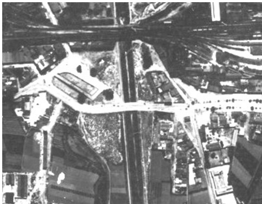
Figura 27: Dall'immagine fotografica dell'epoca (circa 1937) si riconosce il tracciato del corso dei Mille che percorre il vecchio ponte delle Teste e prosegue sul ponte in calcestruzzo armato realizzato sul nuovo letto del fiume, allora appena raddrizzato ed incanalato.
