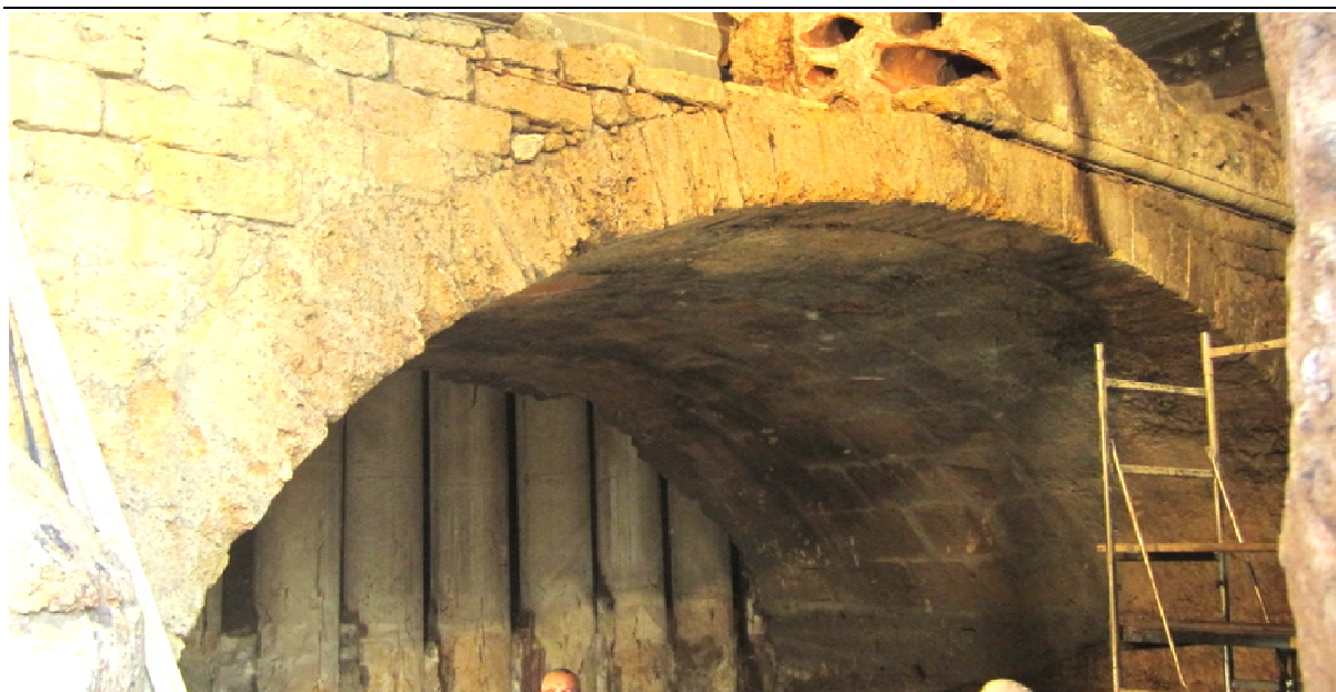
Figura 35: Le immagini mostrano i pali in conglomerato cementizio armato di sostegno delle spalle del nuovo ponte bimodale (tram-autoveicoli), infissi nella zona centrale del ponte. Può notarsi la zona connotata da mattoni laterizi che vennero utilizzati per raccordare le parti di ampliamento del ponte rispetto a quelle originarie.
