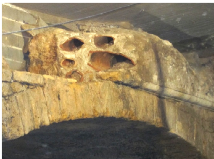
Figura 34: Il crollo parziale del parapetto mette in mostra cinque condotte d'acqua incassate al di sotto del paramento esterno.
