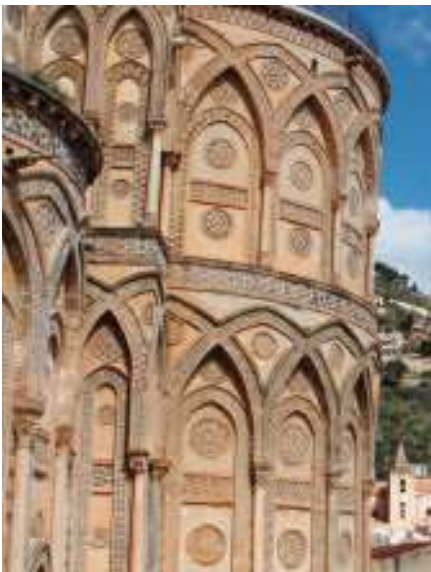
Fig. 8. Veduta delle absidi del Duomo dalla Sala del Rinascimento.
