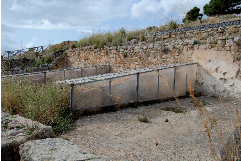
Figg. 1, 2 - Solunto, isolato 7 unità XII: partizione realizzata con muro in adobe su base in materiale lapideo protetta da teca in ferro e plexiglass e un particolare (2014).
