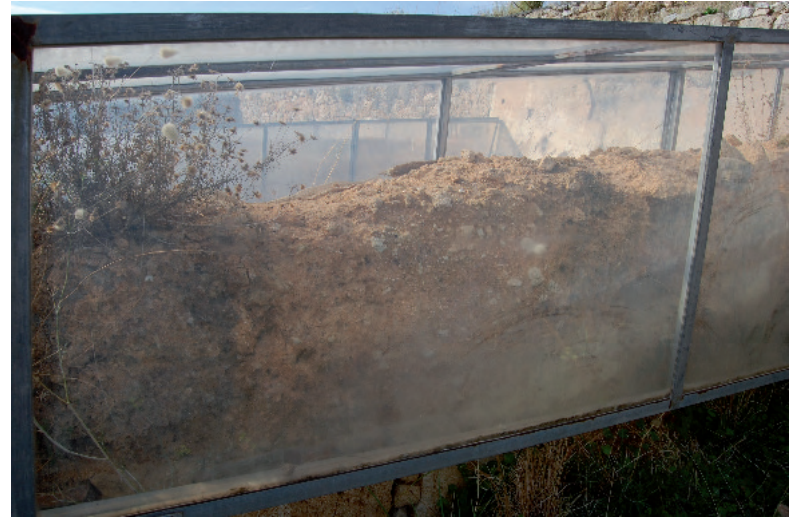
Figg. 1, 2 - Solunto, isolato 7 unità XII: partizione realizzata con muro in adobe su base in materiale lapideo protetta da teca in ferro e plexiglass e un particolare (2014).
