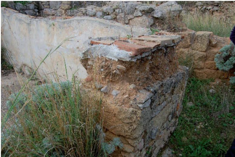
Figg. 3, 4 - Solunto, isolato 5: reperto di muro in adobe su base in materiale lapideo, con cresta rivestita da elementi in laterizio ancorati con malta cementizia e un particolare (2014).
