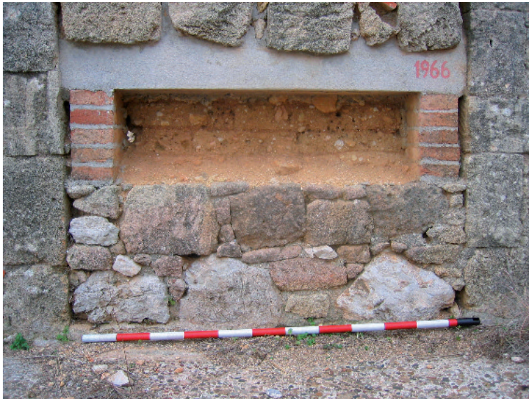
Figg. 5, 6 - Solunto, isolato 7 unità XIV: muro in adobe realizzato come tamponatura di un vano (ph. M. Schiera 2007 a sinistra, ph. F. D'Amaro 2013 a destra).
