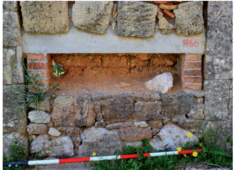
Figg. 5, 6 - Solunto, isolato 7 unità XIV: muro in adobe realizzato come tamponatura di un vano (ph. M. Schiera 2007 a sinistra, ph. F. D'Amaro 2013 a destra).
