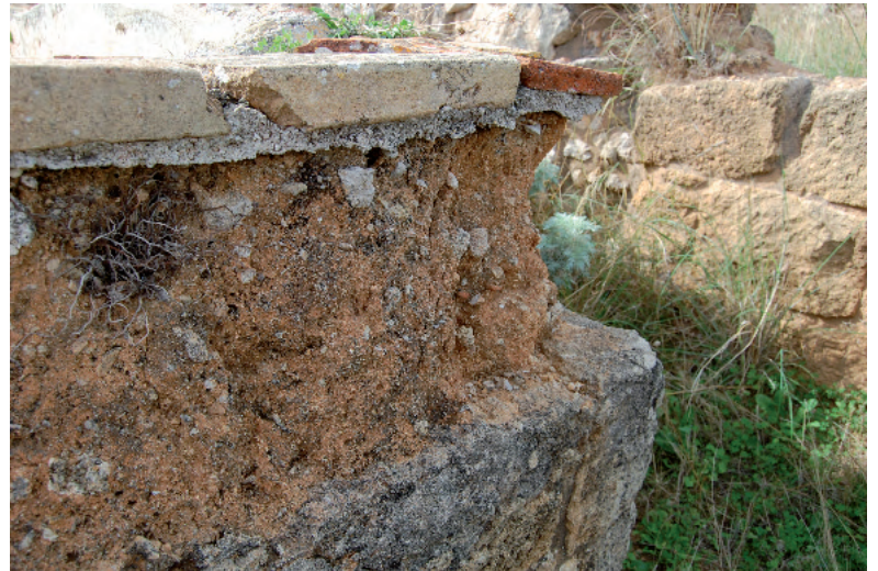
Figg. 3, 4 - Solunto, isolato 5: reperto di muro in adobe su base in materiale lapideo, con cresta rivestita da elementi in laterizio ancorati con malta cementizia e un particolare (2014).
