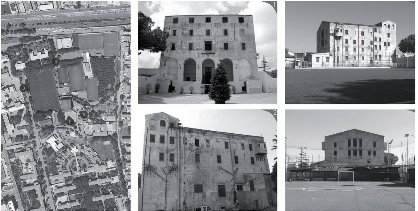
Fig. 8 - Tesi di Laurea di Giovanna Ferrante, Una residenza sanitaria assistenziale per la Vignicella. Ex Real Casa dei Matti, rell. G. De Giovanni, G. F. Tuzzolino, Università degli Studi di Palermo A.A. 2012/2013: a sinistra, vedute del complesso della Vignicella; a destra, veduta area dell'area di progetto..
