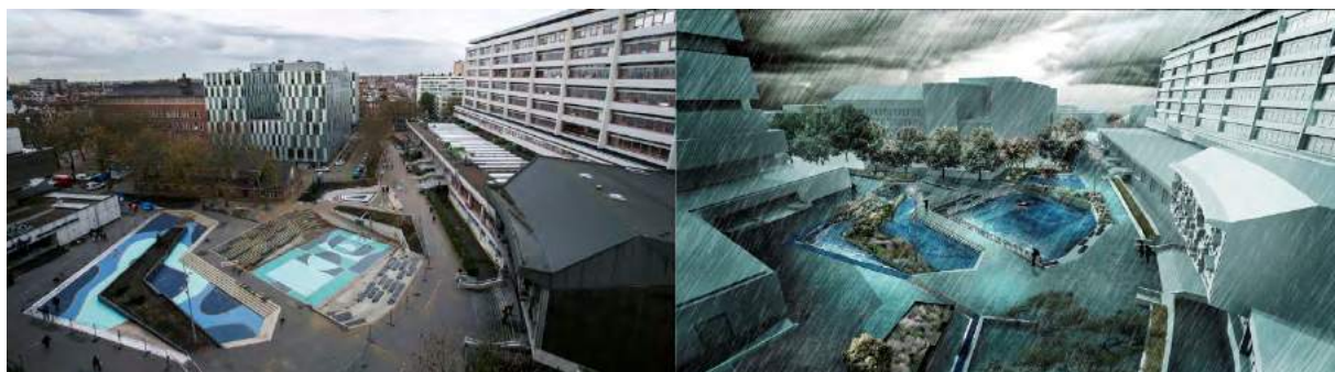
Figura 3 | Rotterdam, Waterplein Benthemplein (De Urbanisten, 2011-2013). Fonte: www.rotterdamclimateinitiative.nl .
