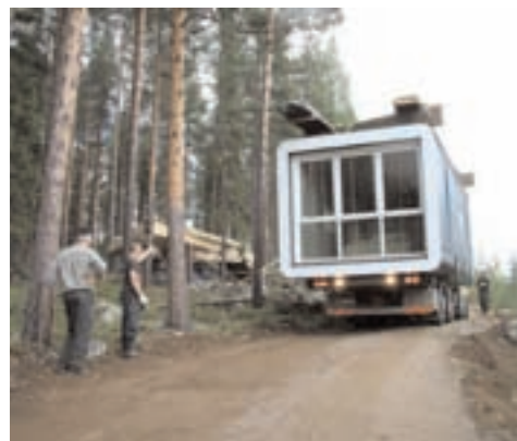
Fase di trasporto di un modulo abitativo.
