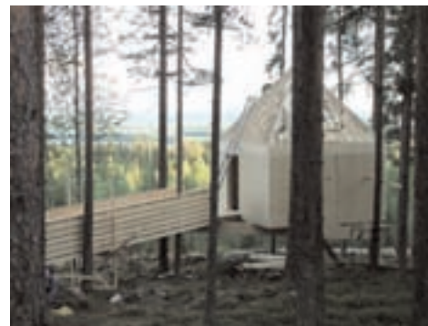
Il Blue Cone in costruzione.
