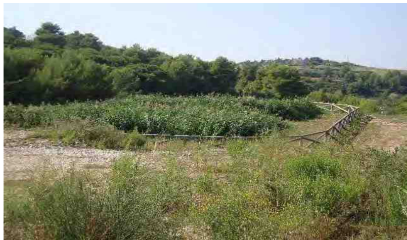
Figura 2: Sistema a flusso sommerso orizzontale (San Carlo, Solvay Chimica Italia spa).
