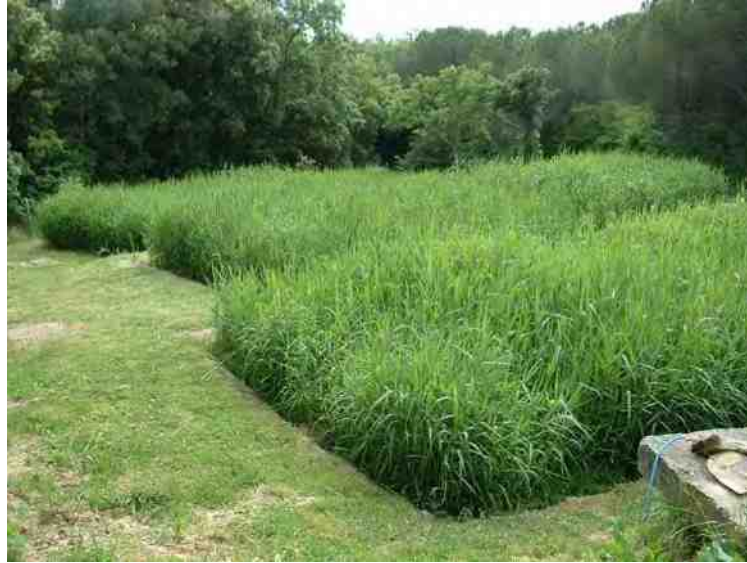
Figura 4: Sistema a flusso sommerso verticale (cantina vitivinicola Tenuta dell'Ornellaia).
