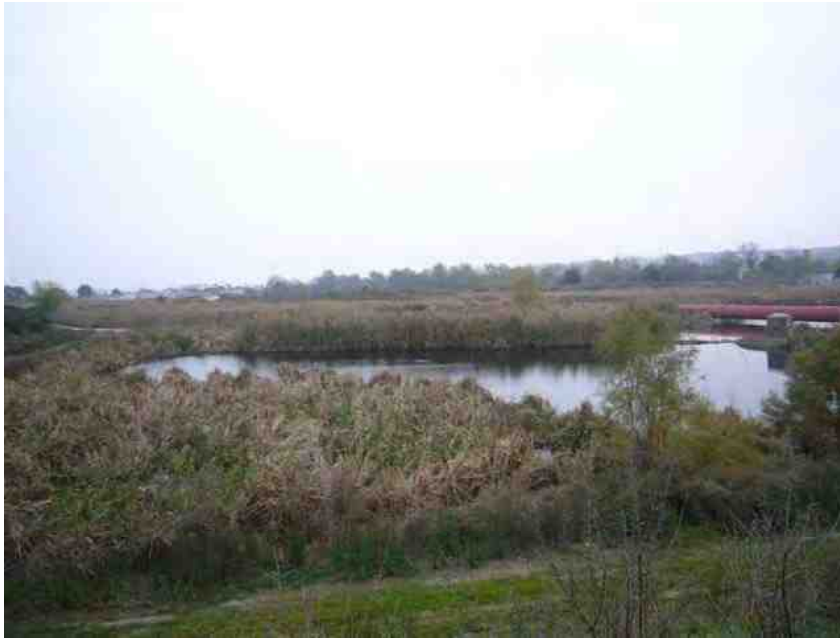
Figura 9: sistema di post-trattamento del depuratore di Jesi (60.000 Abitanti Equivalenti).
