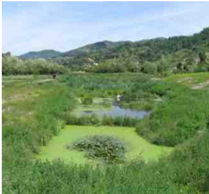
Figura 5: Sistema a flusso libero (impianto di Dicomano).
