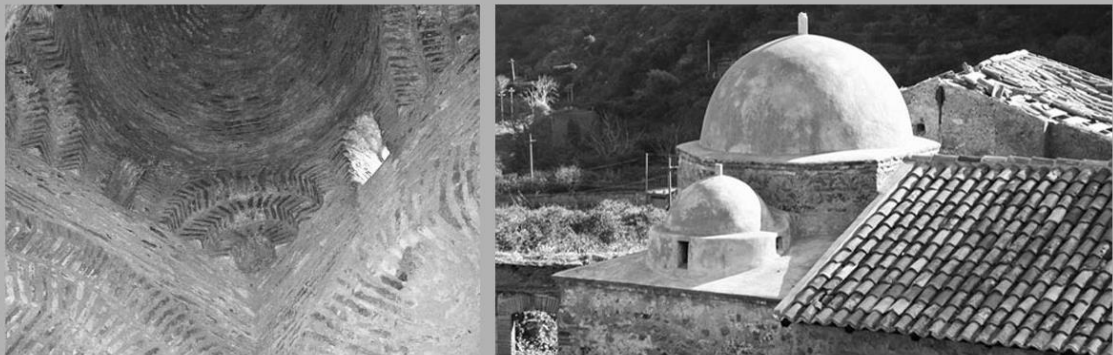
Particolare del raccordo angolare; copertura del presbiterio
