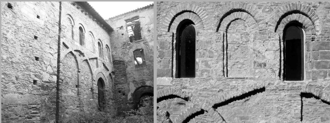
S. Maria di Mili. A sinistra, la muratura medievale della parete sud addossata all'allungamento del XVI sec. A destra, Particolare della decorazione ad archi intrecciati
