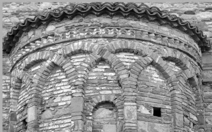
S. Giovanni Teriste. A sinistra, particolare della muratura del transetto A destra, particolare della decorazione ad archi intrecciati dell'abside
