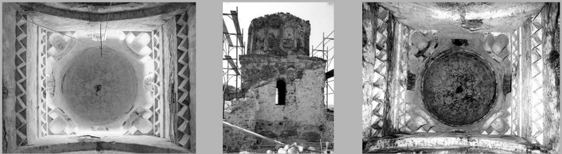
Chiesa di San Giovanni Theriste, la cupola oggi (a sinistra) e prima dei restauri (al centro e a destra)
