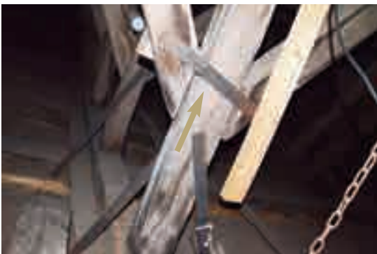
6.4.d - Rinforzo dell'incastro monaco-saette mediante arpioni metallici.
