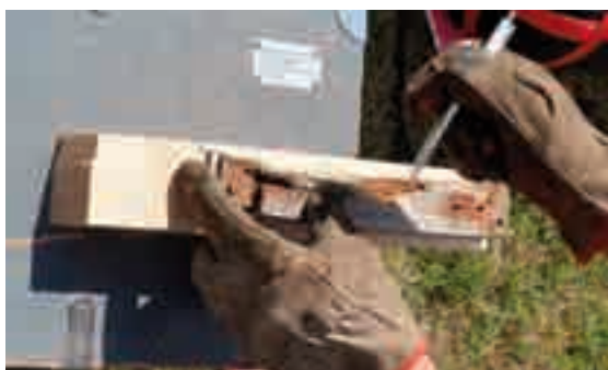
3.13, 3.14 - Nelle parti ove lo strato danneggiato è stato rimosso, vengono realizzate riparazioni con legno della stessa essenza. Tali inserti sono fatti misurando le zone danneggiate e realizzati leggermente più grandi per poter meglio adattarsi alle fessure.
