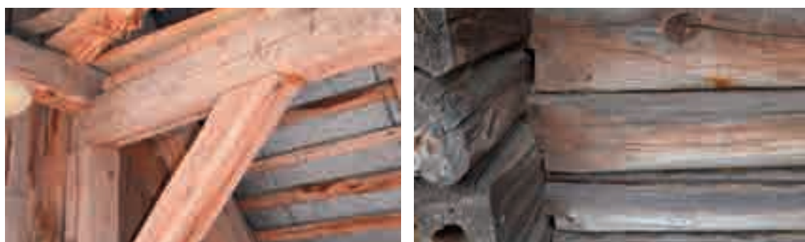
Fig. 1 - Marchi del carpentiere negli elementi della copertura e dei setti verticali lignei.
