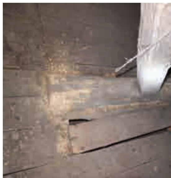
Figg. 51, 52 - A sinistra: tavola in legno scortecciata male e posizionata nel sottotetto durante i lavori di manutenzione; a destra: gli insetti della tavola scortecciata male si sono diffusi in altre strutture nel sottotetto.
