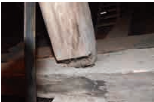
6.3.a - Disconnessione fra monaco e colonnello dovuto alle fessurazioni da ritiro. Bisogna consolidare il nodo senza trasferire particolari sforzi alla struttura (vedasi Fig. 38).
