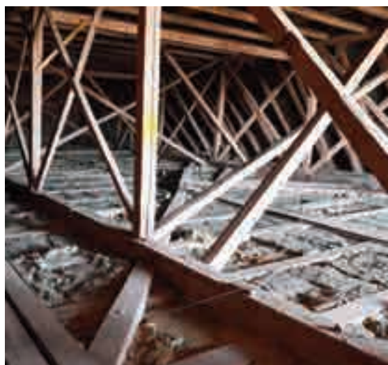
Fig. 8 - Struttura della copertura.
