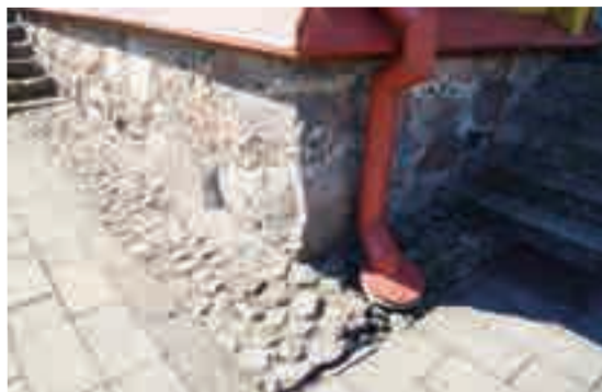
Fig. 4 - Dettaglio delle fondazioni e pluviali discendenti.
