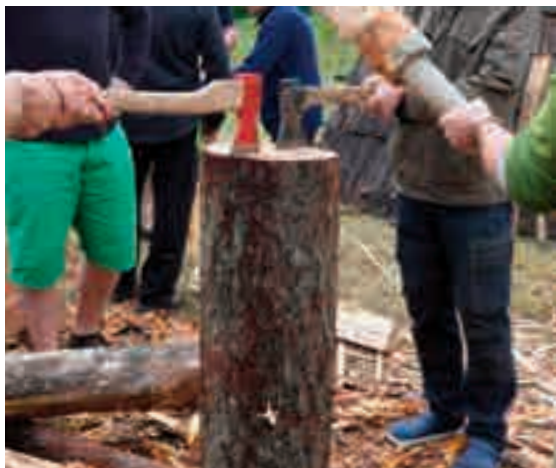
4.1, 4.2 - Il tronco, di giusta altezza, si taglia in due parti, mediante una o due asce e a colpi di mazzuolo.
