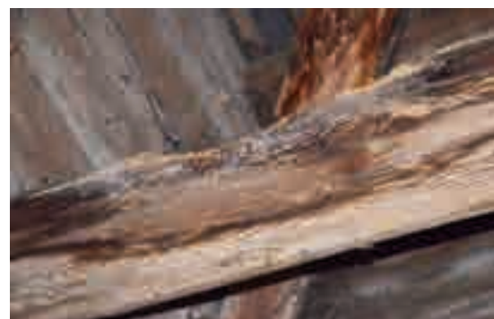
Figg. 16, 17 - Tronchi a diretto contatto con l'acqua, la quale penetra del vecchio rivestimento della copertura. Nelle foto si vedono non solo alterazione del colore, ma anche riduzione del volume.
