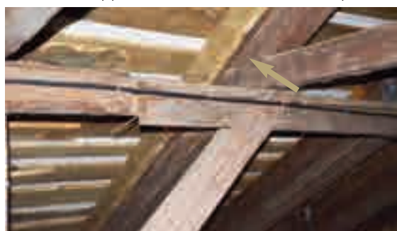
8.1.e - Sostituzione di un puntone e discontinuità fra le parti dello stesso elemento.
