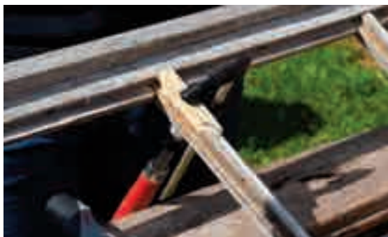
3.15, 3.16 - Prima di inserire nel telaio tali inserti, le parti interessate vengono bagnate con un liquido a base di colla vinilica. Infine, gli inserti lignei sono applicati mediante colla poliuretanica od uno strato sottile di PVA: tali elementi sono resi solidali col telaio mediante una morsa fino a perfetto incollaggio.
