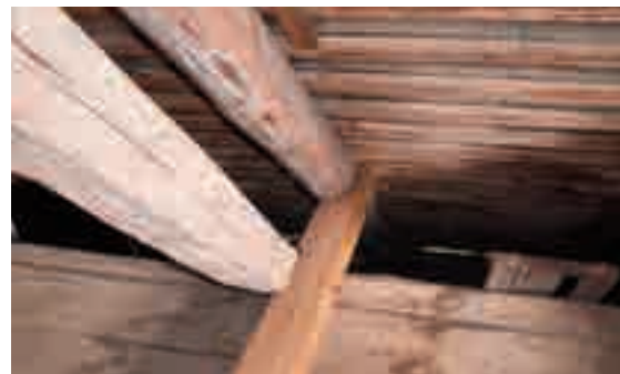
7.2.d - Sostituzione di sottocatene ammalorate con nuovi elementi lignei. Sarebbe bastato lasciare la catena antica e sovrapporre ad essa (fasciatura) l'elemento di consolidamento.
