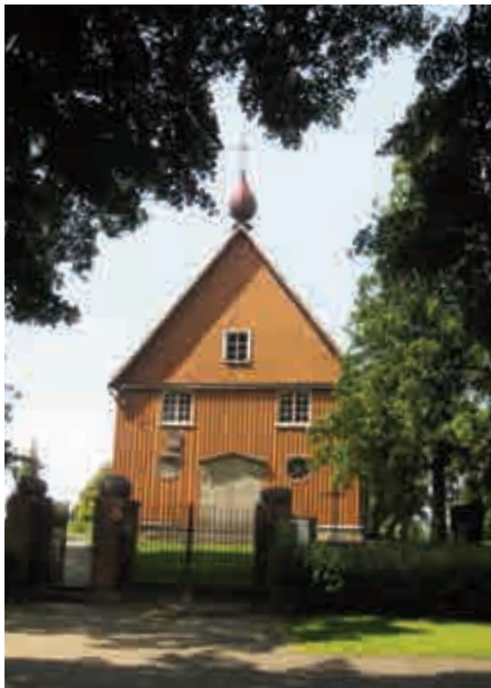
Fig. 1 - Chiesa cattolica di Ukrinai (2013).
