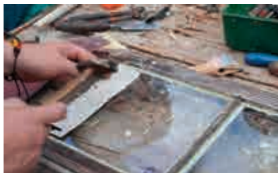
3.25, 3.26 - Rinforzo dell'alloggiamento del vetro con chiodi di metallo. Il vetro viene protetto da uno strato di carta prima di fissare con i chiodi le parti che lo ancorano al telaio.
