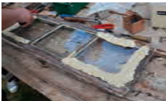
3.27, 3.28 - Dopo aver fissato il vetro, si applica un abbondante strato di Kitas su tutto il perimetro. Con l'ausilio di una lama viene rimosso lo strato in eccedenza, comprimendo tale prodotto, nel contempo, negli spazi tra il telaio e il vetro, spazi in cui la lama deve potere scorrere. Il processo completo di asciugatura della miscela impiega circa un mese.
