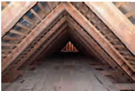
Fig. 5 - Sistema delle incavallature.
