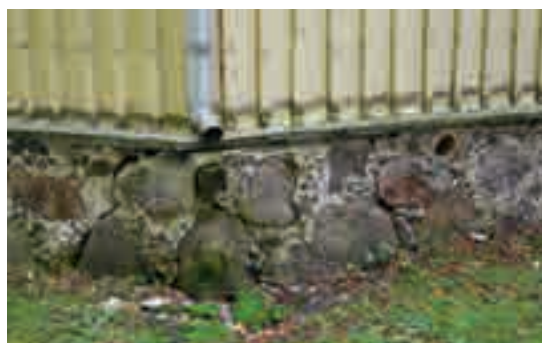
Figg. 3,4 - Fondazioni in pietra di grandi dimensioni consolidate con la miscela di cemento e piccole pietre.
