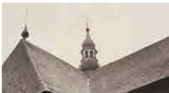
Fig. 12 - Torre della chiesa prima di lavori di restauro. [27]
