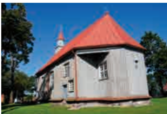
Fig. 3 - Parte anteriore della chiesa.
