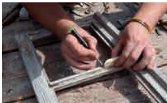
3.13, 3.14 - Nelle parti ove lo strato danneggiato è stato rimosso, vengono realizzate riparazioni con legno della stessa essenza. Tali inserti sono fatti misurando le zone danneggiate e realizzati leggermente più grandi per poter meglio adattarsi alle fessure.
