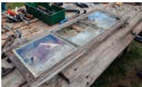
3.25, 3.26 - Rinforzo dell'alloggiamento del vetro con chiodi di metallo. Il vetro viene protetto da uno strato di carta prima di fissare con i chiodi le parti che lo ancorano al telaio.
