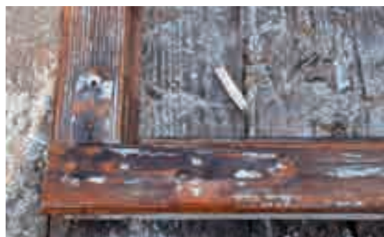
3.19, 3.20 - I fori lasciati dalla rimozione dei chiodi metallici devono essere riempiti con perni lignei e PVA. In questo modo i nuovi chiodi avranno una migliore presa.
