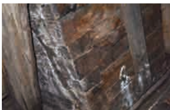
Figg. 14, 15 - Presenza di marciume nei setti verticali lignei nella zona interna, mixomiceti (funghi mucillaginosi).
