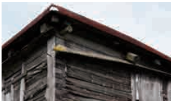
Figg. 8, 9 - I danni al rivestimento esterno della copertura fanno accumulare l'acqua dentro il sottotetto, aumentando il livello dell'umidità (più di 20%). Tale dissesto può causare attacchi di funghi alle strutture della copertura.
