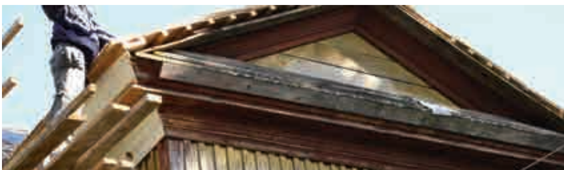
Fig. 47 - Opere di demolizione e sostituzione del cornicione.
