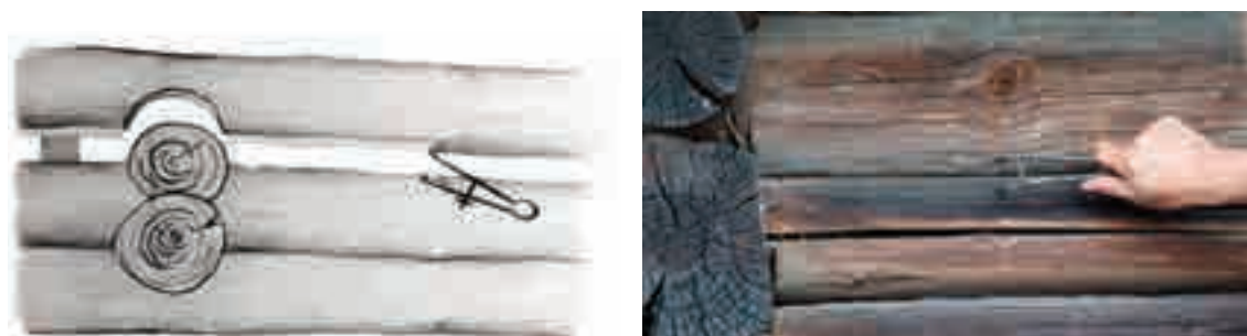
Figg. 6, 7 - Marcatura delle scanalature effettuate su tronco superiore con un apposito atrezzo che lascia una visibile incisione. [2]
