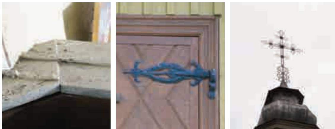
Fig. 4 - Vari elementi metallici, utilizzati come irrigidimenti ed elementi decorativi nell'edilizia.
