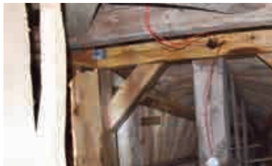
1.1. a,b - Ricostruzione della parte sommitale della torre dopo l'incendio avvenuto durante la Seconda Guerra Mondiale. Le nuove connessioni non sono state realizzate secondo i metodi tradizionali.
