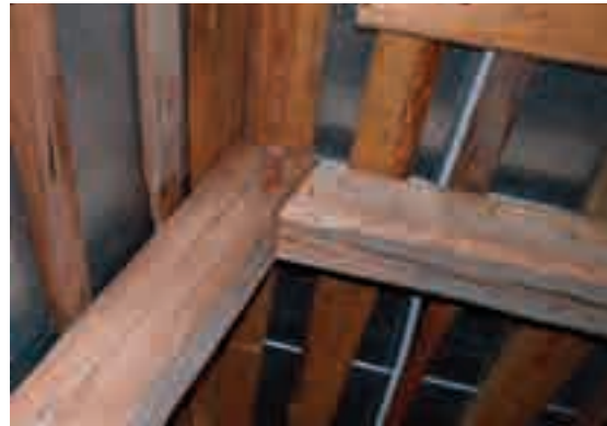
Figg. 32, 33 - A sinistra: sconnessione fra monaco e catena; a destra: affrancamento del chiodo ligneo.
