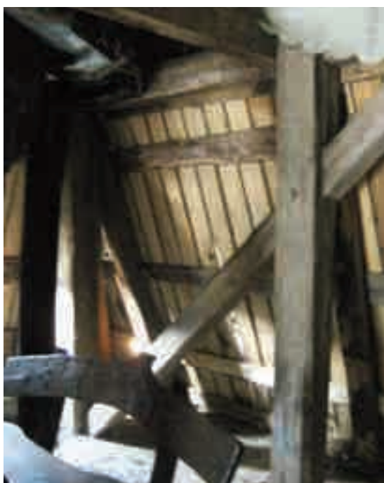
Fig. 11 - Struttura a telaio del campanile (zona basamentale).
