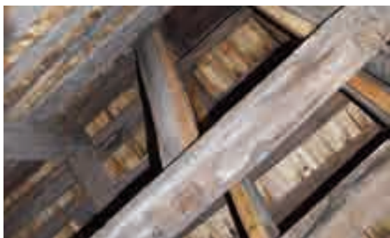
9.1.a - Rinforzi lignei nella costruzione della torre frontale. Intervento corretto e poco invasivo.
