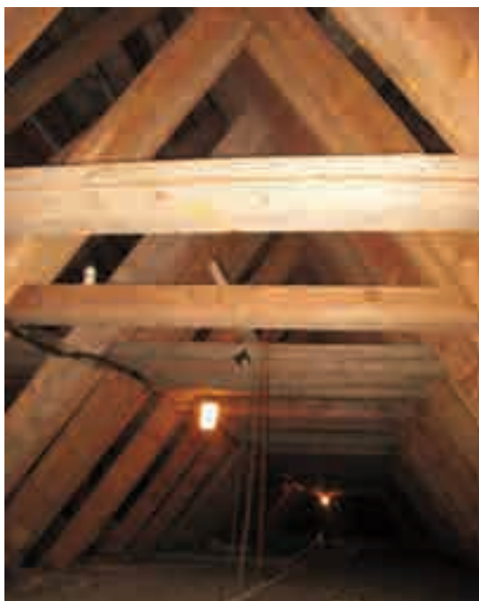
Fig. 10 - Incavallature a forma di forbice.
