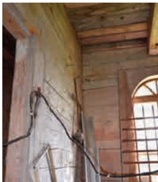
Fig. 14 - I setti verticali lignei del campanile.
