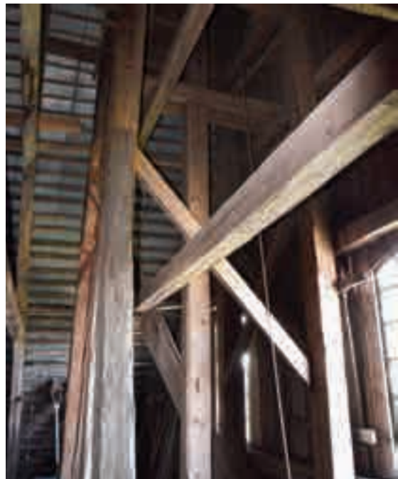
Fig. 11 - Struttura a telaio della torre.
