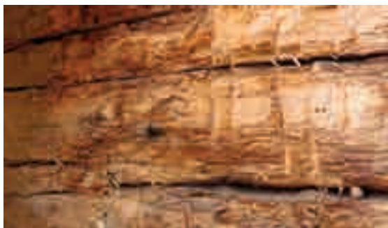
Figg. 6, 7 - A sinistra: il degrado del rivestimento esterno, dovuto alla umidità e l'acqua piovana, ha causato gravi danni ai setti verticali lignei; a destra: la mancanza di manutenzione degli infissi può portare danni ai setti verticali, dovuti alle intemperie e all'umidità.
