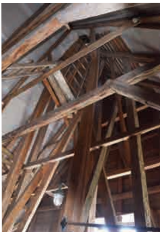
Fig. 8 - Struttura della torre a telaio.
