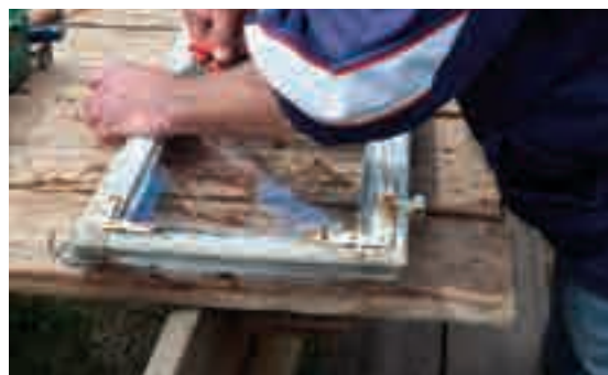
3.1, 3.2 - Rimozione dei vetri dal telaio. Vengono estratti i chiodi metallici che fissano il vetro e successivamente si rimuove il vetro con cura.
