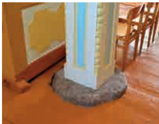
Fig. 6 - Dettaglio della pavimentazione.
