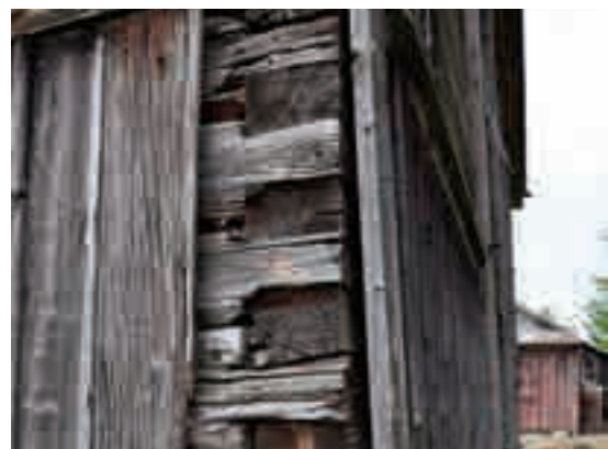
Fig. 2 - Sistema costruttivo con connessione ad anima o forcilla; vista dall'interno e dall'esterno.
