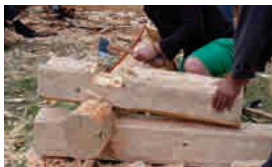
1.33, 1.34 - Terminata la realizzazione delle scanalature, viene definitivamente completato l'incastro, tagliando fino alla linea segnata precedentemente.
