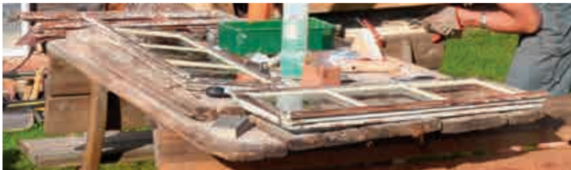
3.29 - Infine, sono reinserite le staffe e i ganci. Il telaio è così ora pronto per la verniciatura.
