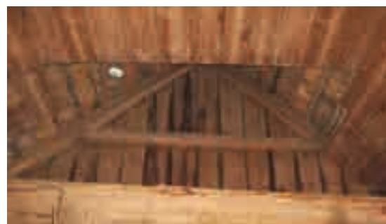
Fig. 15 - Struttura della copertura della cappella.
