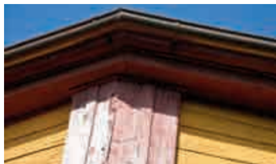
Fig. 4 - Dettaglio del cornicione.
