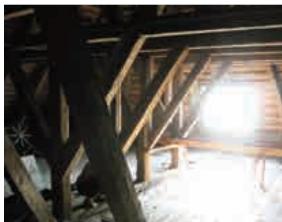
Fig. 4 - Sistema delle incavallature.
