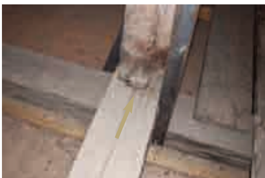
6.3.c - Dettaglio unione monaco-colonnello tramite inserimento di un cuneo. Questo elemento non permette movimenti del monaco.
