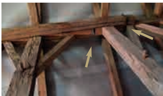
4.1.a,b - A sinistra: distacco fra gli elementi longitudinali rinforzato tramite un'altro elemento ligneo e cerchiature metalliche; a destra: attacchi fungini ed insetti dovuti alla umidità e l'acqua piovana. Bisogna procedere con una buona aerazione del sottotetto, la piallatura delle parti ammalorate e successivo trattamento con prodotti fungicidi.
