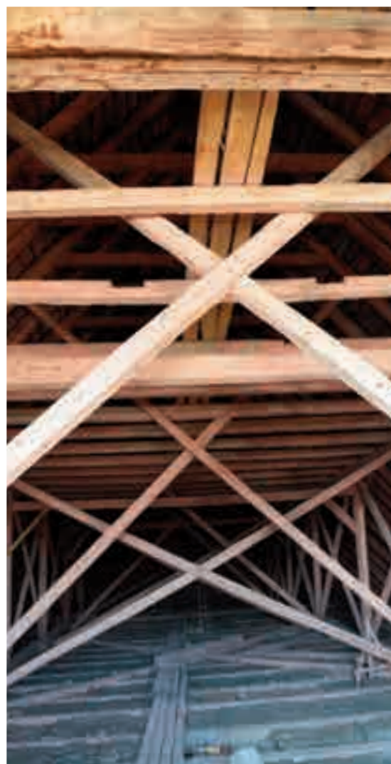
Fig. 11 - Vista generale delle incavallature.
