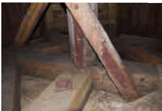
Fig. 8 - Connessione di elementi della base del tetto.
