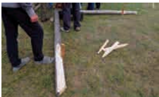
2.5 - A sinistra: a terra si segna la distanza tra i setti verticali, in questi punti vengono incassati i puntelli e si prova ad inserire i puntoni preparati con un angolo adeguato; a destra: quando l'angolo è determinato, successivamente vengono segnate le linee di taglio.
