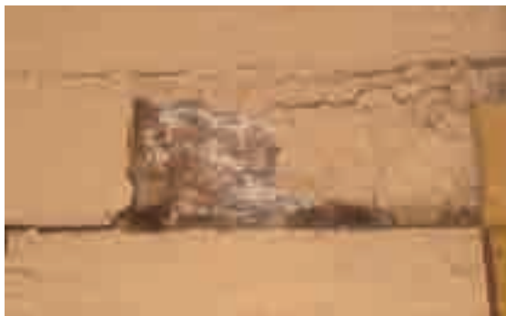
Figg. 12, 13 - La prima conseguenza di attacco da parte di funghi, l'alterazione del colore naturale del materiale. In questo esempio intonaco ed verniciatura distaccata dai setti verticali lignei a causa di emergenza di funghi.
