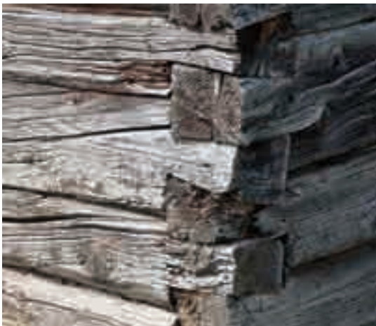
Figg. 5,6 - Foto di dettaglio del sistema costruttivo con incastri a coda di rondine; le viste dall'esterno.
