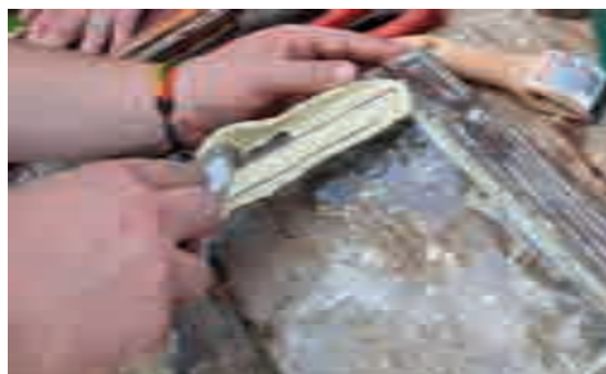
3.27, 3.28 - Dopo aver fissato il vetro, si applica un abbondante strato di Kitas su tutto il perimetro. Con l'ausilio di una lama viene rimosso lo strato in eccedenza, comprimendo tale prodotto, nel contempo, negli spazi tra il telaio e il vetro, spazi in cui la lama deve potere scorrere. Il processo completo di asciugatura della miscela impiega circa un mese.
