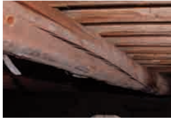
Figg. 30, 31 - A sinistra: esempio di cipollatura; a destra: tendenza del puntone a flettersi e causa delle fessurazioni da ritiro.
