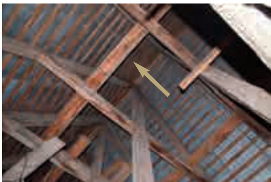
6.3.d - Irrigidimento orizzontale mediante l'impiego di tavole tra le sottocatene delle incavallature. Interventi come questo sono efficaci e poco invasivi.
