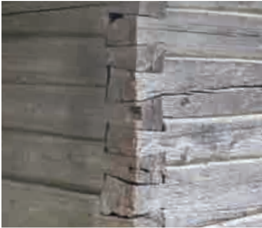
Figg. 3,4 - Foto di dettaglio del sistema costruttivo con incastri a coda di rondine; le viste dall'esterno.
