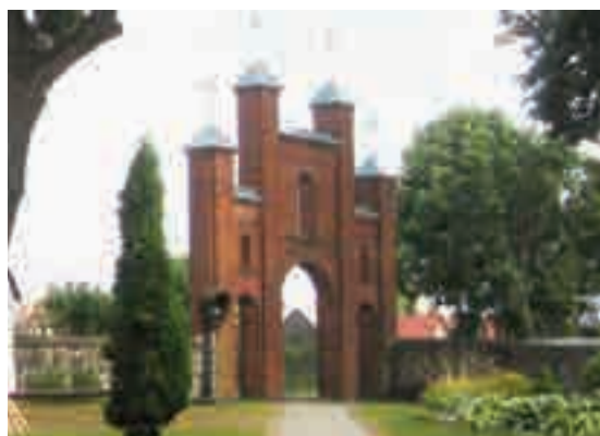
Fig. 3 - Cancelli principale in mattoni.
