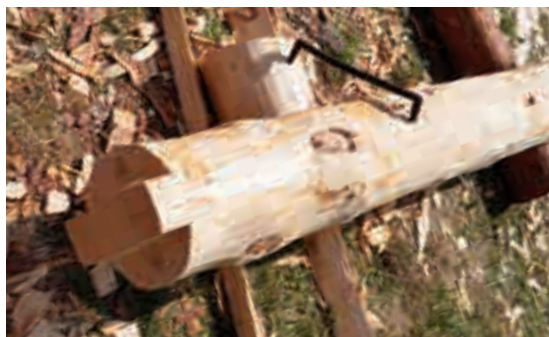
1.11, 1.12 - Il dente viene ottenuto con seghe, asce e scalpelli. Se nella zona di taglio ci sono dei rami è preferibile lavorare con la sega, perchè l'ascia, meno precisa, può rimuovere parti di legno utile.
