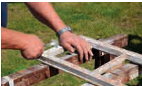
3.9, 3.10 - La rimozione della vecchia vernice dal telaio viene effettuata mediante raschietti e carta vetrata. Tale rimozione dello strato di pittura va eseguita senza danneggiare il legno, dopodiché il telaio viene accuratamente carteggiato.
