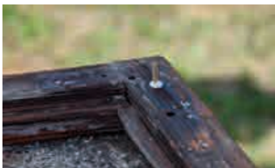
3.19, 3.20 - I fori lasciati dalla rimozione dei chiodi metallici devono essere riempiti con perni lignei e PVA. In questo modo i nuovi chiodi avranno una migliore presa.
