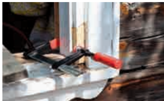
3.15, 3.16 - Prima di inserire nel telaio tali inserti, le parti interessate vengono bagnate con un liquido a base di colla vinilica. Infine, gli inserti lignei sono applicati mediante colla poliuretanica od uno strato sottile di PVA: tali elementi sono resi solidali col telaio mediante una morsa fino a perfetto incollaggio.
