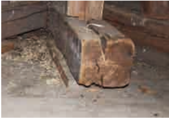
Figg. 30, 31 - A sinistra: esempio di cipollatura; a destra: tendenza del puntone a flettersi e causa delle fessurazioni da ritiro.
