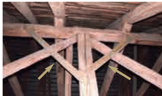
5.1.a, b - Rinforzi dei controventamenti lignei per evitare movimenti delle strutture di copertura dovuti al vento. Semplici interventi come questo sono accettabili perché riconoscibili, reversibili, poco invasivi e, in fondo, efficaci.
