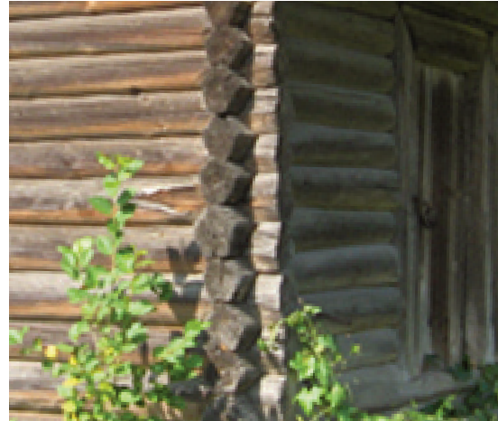
Figg. 1,2 - Esempi del sistema costruttivo con tronchi a sezione esagonale.
