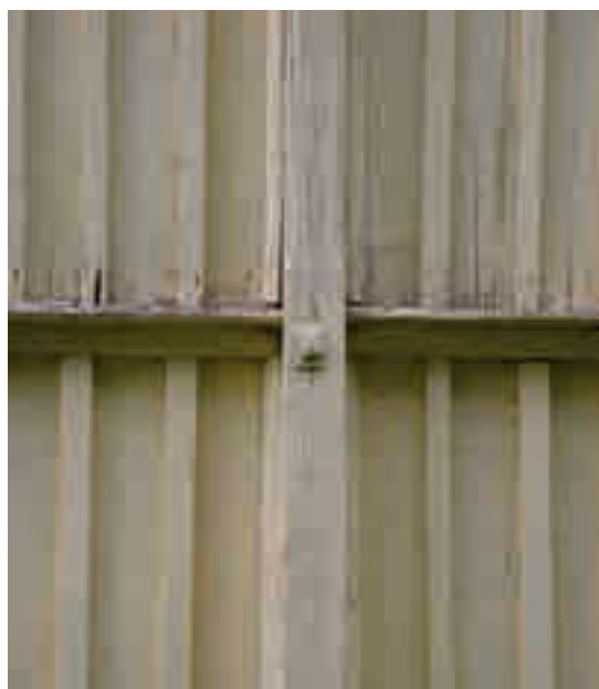
Figg. 1,2 - Struttura secondaria di rinforzo ed irrigidimento delle pareti perimetrali, vista dall'interno ed esterno.
