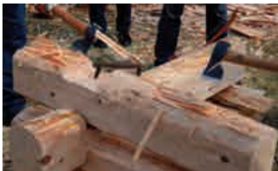
1.31, 1.32 - Dopo aver sgrossato il tronco con l'ascia, realizzando le scanalature, si passa ad una lavorazione più accurata, con una piccola ascia a lama ricurva. Proprio con tale strumento si riesce a realizzare scanalature semicircolari che si adattano perfettamente al tronco inferiore.
