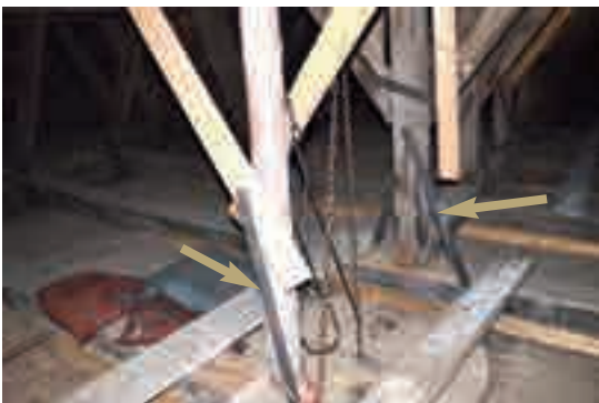
6.4.c - Consolidamenti tra monaco e colonnello tramite arpioni metallici.
