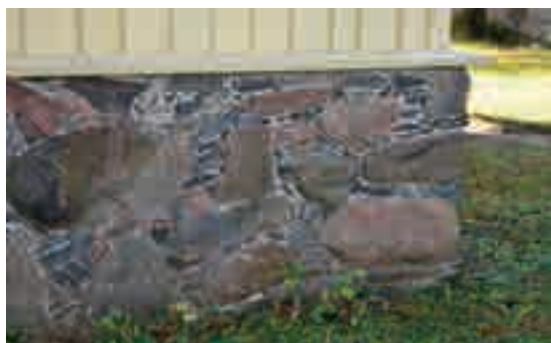
Figg. 3,4 - Fondazioni in pietra di grandi dimensioni consolidate con la miscela di cemento e piccole pietre.
