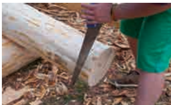
1.9, 1.10 - Il tronco così lavorato è pronto per essere inciso: si segnano le opportune linee di taglio e si procede a creare due incavi opposti nell'estremità del tronco; il tocco di legno rimanente fra di essi si chiama dente. Le dimensioni di un dente sono di circa 6 cm di lunghezza e 8 cm di spessore.
