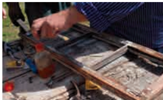
3.21, 3.22 - Le aree a contatto col vetro sono bagnate con liquido realizzato sciogliendo in alcool escrementi di tarli. Questo liquido colma i vuoti interstiziali e previene la penetrazione di umidità chiudendo i pori, inoltre impedisce la fuoriuscita dell'olio di Kitas (miscela di gesso e olio di lino).
