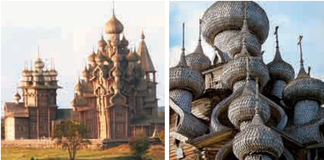
Figg. 1,2 - Complesso di edifici in legno di Kizhi Pogost, Russia (XVIII sec). [1]
