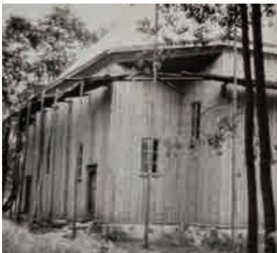
Fig. 1 - Chiesa durante i lavori di recupero. [33]
