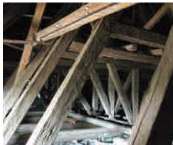
Fig. 5 - Struttura della copertura.
