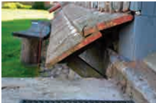
Fig. 5 - Dettaglio della scossalina rompiggocia.
