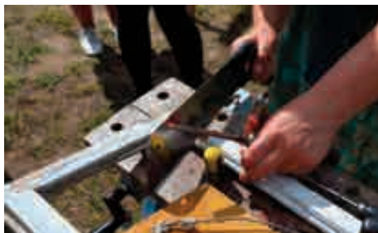
3.7, 3.8 - Con scalpelli e seghe sono rimosse le parti danneggiate a contatto con il telaio ligneo.
