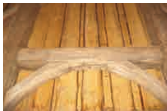
Fig. 13 - Sistema di rinforzo delle pareti.
