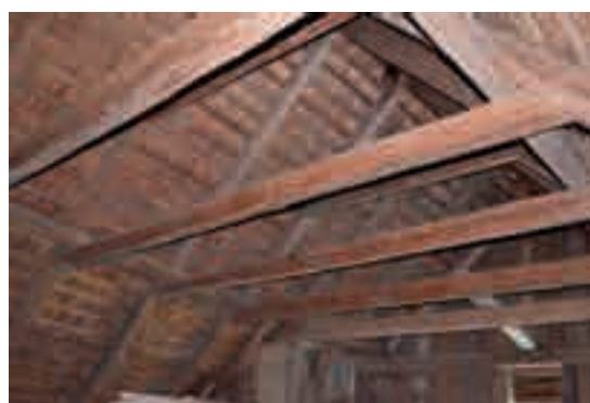
Fig. 5 - Struttura della copertura.
