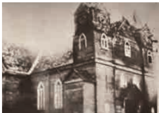
Fig. 7 - Chiesa durante l'incendio. [37]
