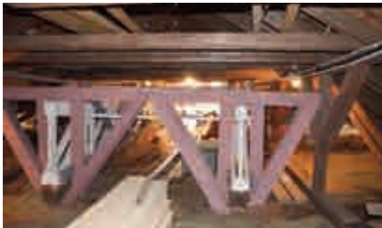
8.2.a - Strutture appoggio della trave reticolare.
