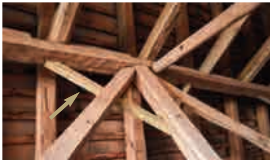
5.1.a, b - Rinforzi dei controventamenti lignei per evitare movimenti delle strutture di copertura dovuti al vento. Semplici interventi come questo sono accettabili perché riconoscibili, reversibili, poco invasivi e, in fondo, efficaci.
