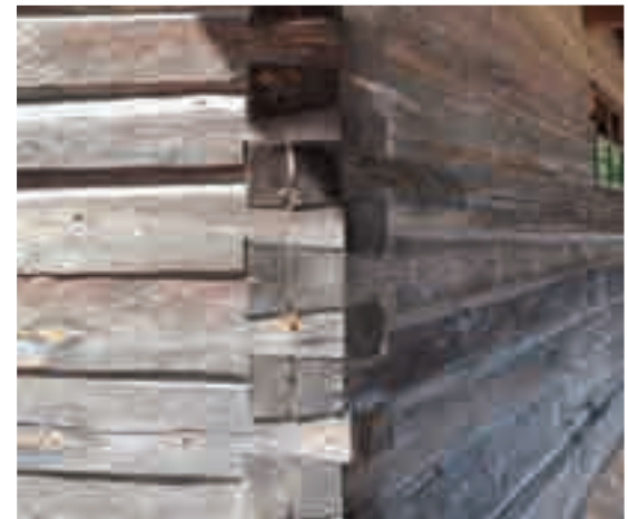
Figg. 5,6 - Foto di dettaglio del sistema costruttivo con incastri a coda di rondine; le viste dall'esterno.
