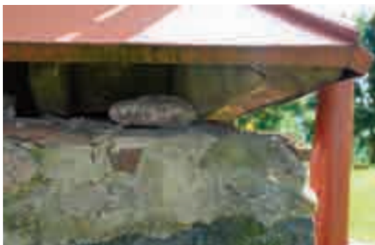
Fig. 4 - Dettaglio della scossalina rompigoocia.
