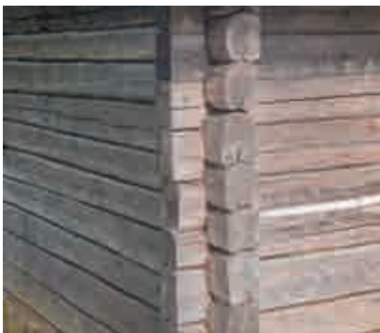
Figg. 5,6 - Esempi del sistema costruttivo con tronchi a sezione praticamente quadrangolare; giunti sopra e sotto e scanalatura inferiore.
