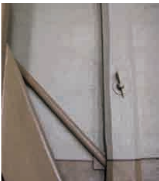
Figg. 1,2 - Struttura secondaria di rinforzo ed irrigidimento delle pareti perimetrali, vista dall'interno ed esterno.
