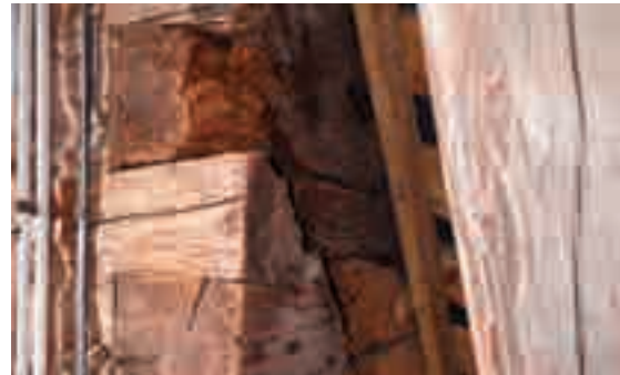
7.2.b - Marcescenze causate da infiltrazioni d'acqua nella struttura di un setto costruito col sist. Blockbau . In questo caso è meglio procedere con protesi lignee (vedasi Fig. 35).
