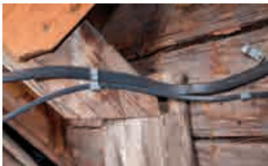
Figg. 26, 27 - Impianti elettrici chiodati direttamente alle strutture lignee della copertura senza protezione.
