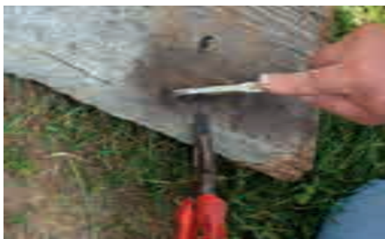
3.5, 3.6 - Successivamente sono rimosse dal fuoco e subito pulite con una spazzola metallica al fine di rimuovere vernice e ruggine. Subito dopo si applica su di esse uno strato a base di resina di pino (catrame vegetale di resina di pino). La superficie metallica da lavorare deve essere molto calda, perchè così il catrame applicato evapora ed asciuga immediatamente. Ed in questo modo, le parti metalliche risultano rinnovate e protette dalle ruggine.
