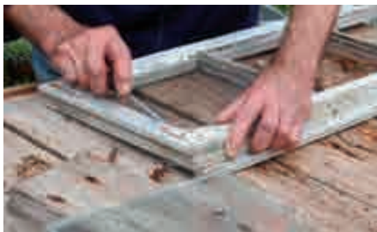
3.3, 3.4 - Smontaggio delle parti metalliche dal telaio: staffe, ganci etc. vengono poste in una brace di carbone ardente per mezz'ora - un'ora.
