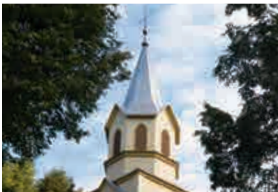
Fig. 10 - Torre del prospetto principale.
