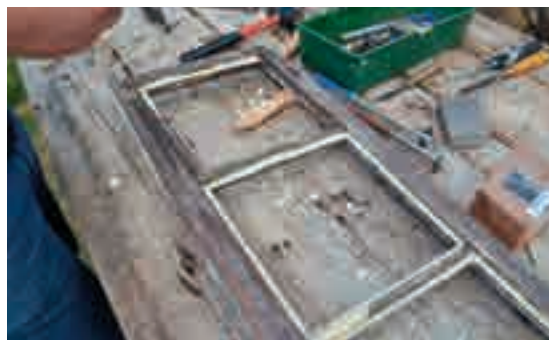
3.23, 3.24 - Quando si asciuga tale liquido a base di escrementi, si applica la miscela di Kitas (miscela di gesso e olio di lino). nelle parti che compongono l'alloggiamento del vetro.
