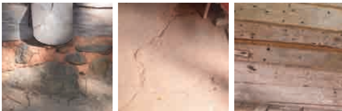
Fig. 2 - Argilla utilizzata per rinforzo delle fondazioni di getto nelle fessurazioni, pavimentazione interna, a costituire struccature utili a colmare gli spazi fra i tronchi dei setti verticali.
