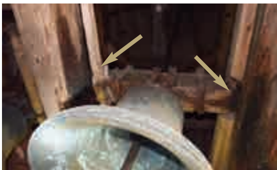
1.1. c,d - Danni alla struttura lignea a sostegno delle campane a seguito dell'inserimento di grandi staffe metalliche.
