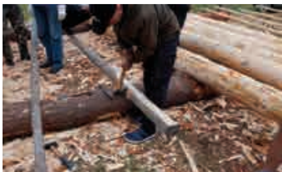
2.3 - Preparazione di un incavo dei puntoni; 2.4 - Preparazione di un alloggiamento per i puntoni nei setti verticali.
