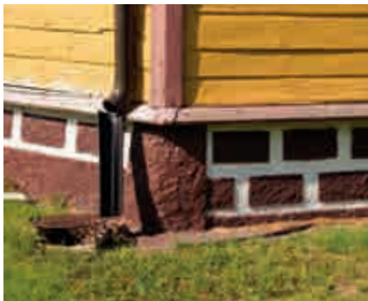
Fig. 3 - Dettaglio delle fondazioni e discendenti pluviali.
