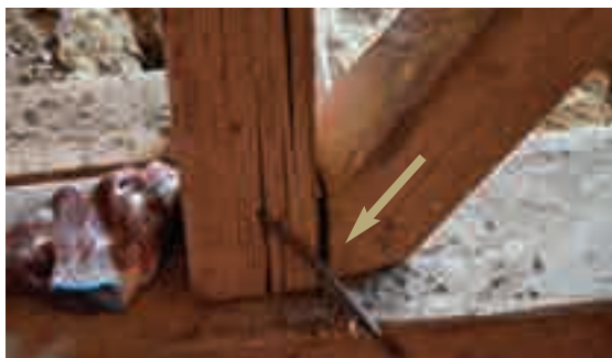
5.1.c - Rinforzo metallico tra monaco e catena. Questo tipo di consolidamento non è efficace ed anche errato, la grappa metallica ha provocato la rottura della fibratura del legno, è sempre meglio procedere con delle cerchiature (vedasi Fig. 41).
