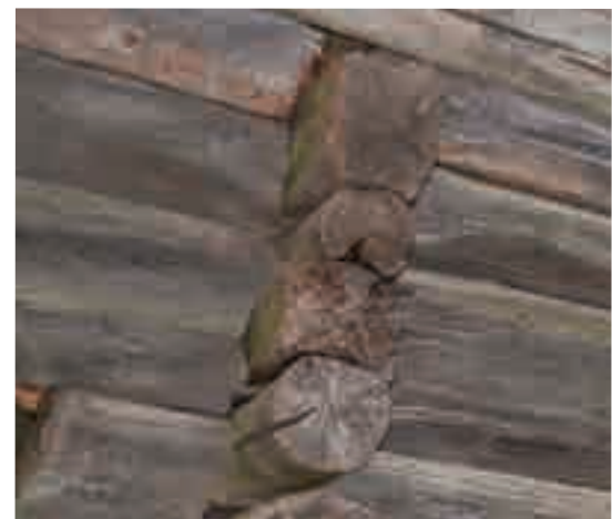
Figg. 3,4 - Esempi del sistema costruttivo con tronchi a sezione circolare; giunti sopra e sotto e scanalatura inferiore.
