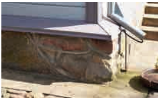
Fig. 1 - Fondazioni in pietra di grandi dimensioni.
