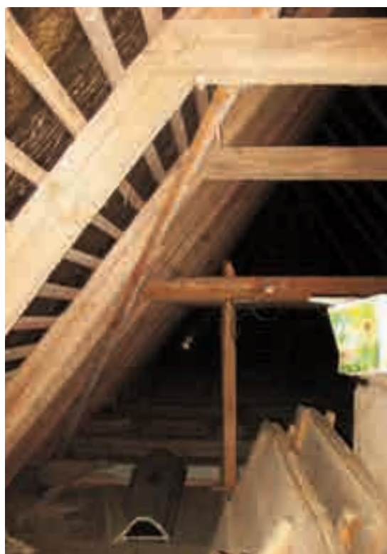
Fig. 6 - Struttura della copertura (2013).
