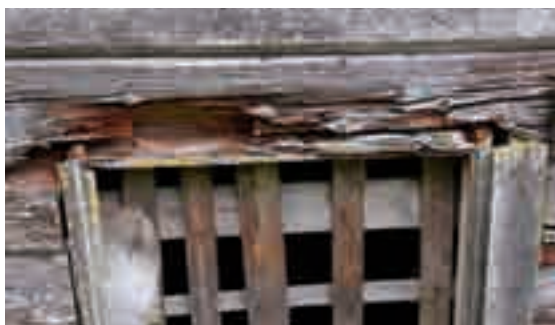
Figg. 4, 5 - A sinistra: i tronchi con funzione di architrave e di davanzale, che costituiscono la parte terminale della struttura, sono soggetti ad essere maggiormente esposti alle intemperie; a destra: gli agenti atmosferici, come il sole e l'acqua, possono danneggiare i tronchi a contatto diretto con le fondazioni. Infatti questi tronchi vanno spesso sostituiti.
