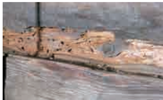
Figg. 20, 21 - A sinistra: esempio di struttura danneggiata irrimediabilmente; anche un numero esiguo di fori di sfarfallamento può nascondere una situazione di degrado molto grave; a destra: travi attaccate da insetti principalmente nell'alburno.
