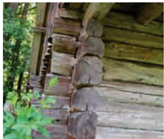
Figg. 5,6 - Esempi del sistema costruttivo con tronchi a sezione praticamente quadrangolare; giunti sopra e sotto e scanalatura inferiore.
