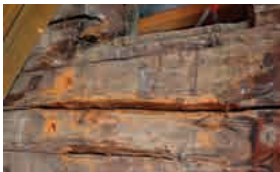
Figg. 22, 23 - A sinistra: gli insetti presenti nei tronchi scortecciati male attaccano le strutture dei setti verticali; a destra: esempio di fori attivi.
