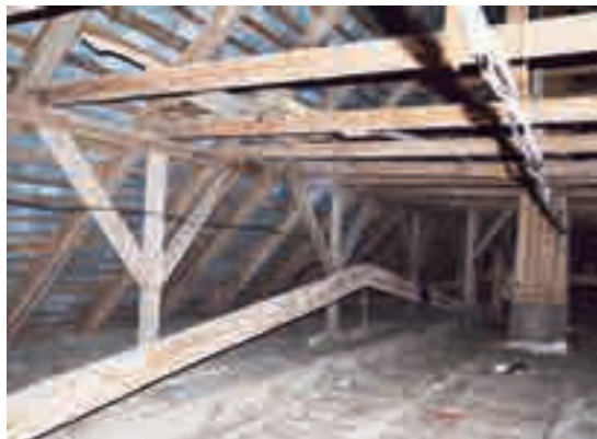
Fig. 7 - Struttura della copertura.
