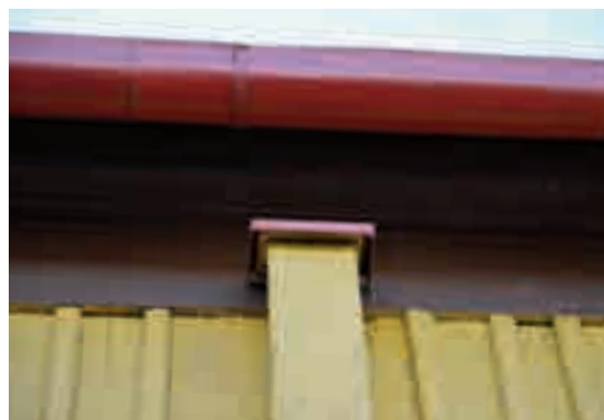
Fig. 5 - Rivestimento d'irrigidimento verticale.
