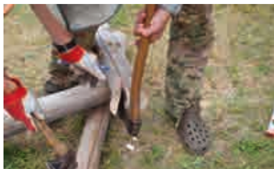
2.6, 2.7 - In questo caso si prepara un incastro a dente. Con la sega si taglia la linea segnata, mentre con l'ascia si spacca il legno preparando "un dente".
