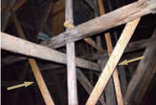
6.4.a - Sostituzioni delle saette ammalorate con nuove tavole. Sempre meglio procedere senza sostituzioni, provando a mantenere il materiale autentico.
