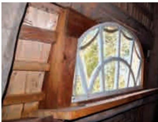
Fig. 3 - Telaio inserito nel rivestimento della copertura.
