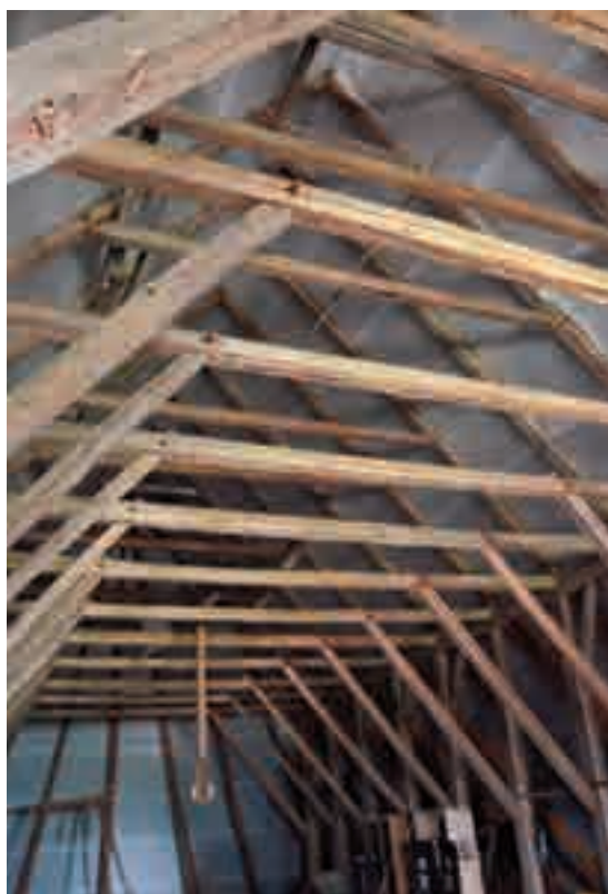
Fig. 10 - Struttura della copertura.
