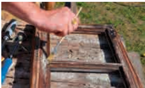
3.21, 3.22 - Le aree a contatto col vetro sono bagnate con liquido realizzato sciogliendo in alcool escrementi di tarli. Questo liquido colma i vuoti interstiziali e previene la penetrazione di umidità chiudendo i pori, inoltre impedisce la fuoriuscita dell'olio di Kitas (miscela di gesso e olio di lino).
