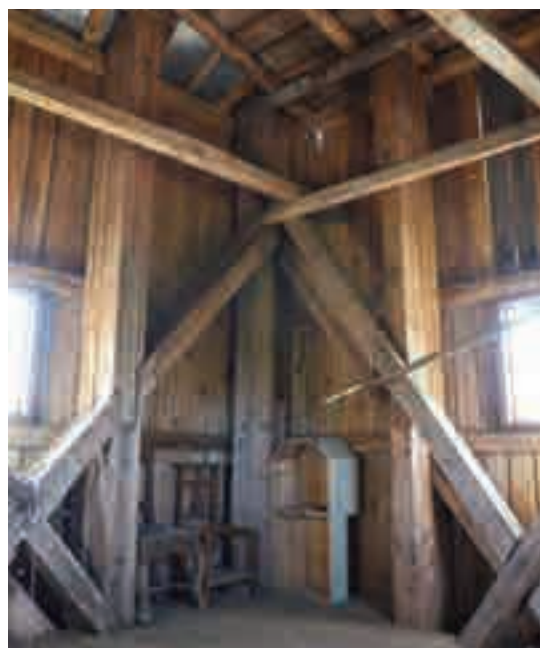
Fig. 14 - Particolare costruttivo del campanile.
