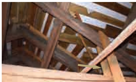
8.1.b - Rinforzo in legno di una sottocaten e un puntone. Questo tipo di intervento è positivo, perchè è riconoscibile ed efficace.
