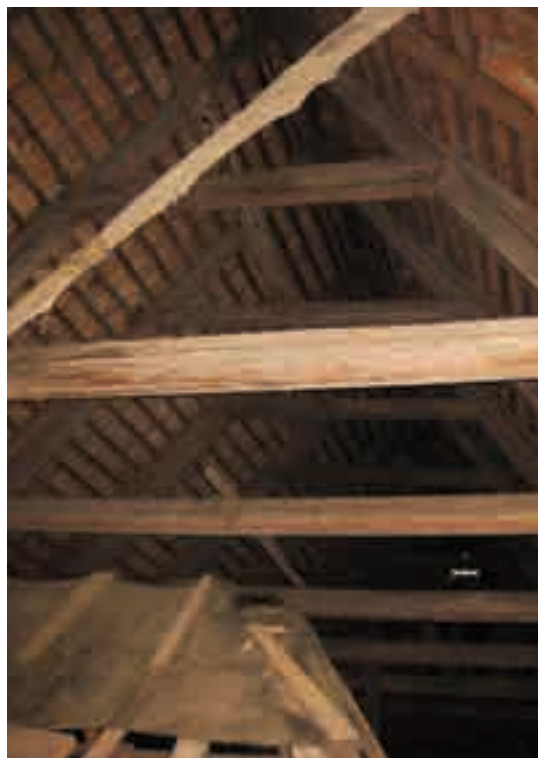
Fig. 10 - Sistema delle incavallature.
