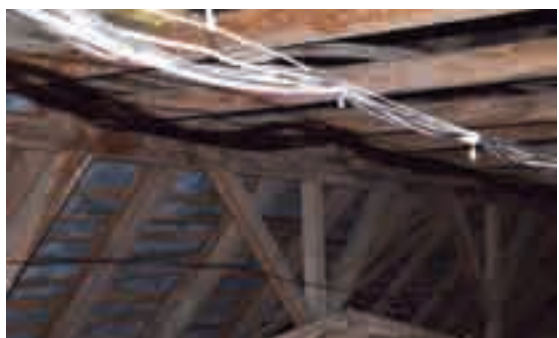
Figg. 28, 29 - Disposizione caotica degli impianti elettrici.
