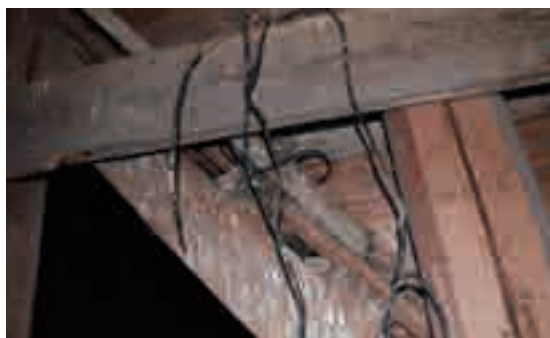
Figg. 26, 27 - Impianti elettrici chiodati direttamente alle strutture lignee della copertura senza protezione.
