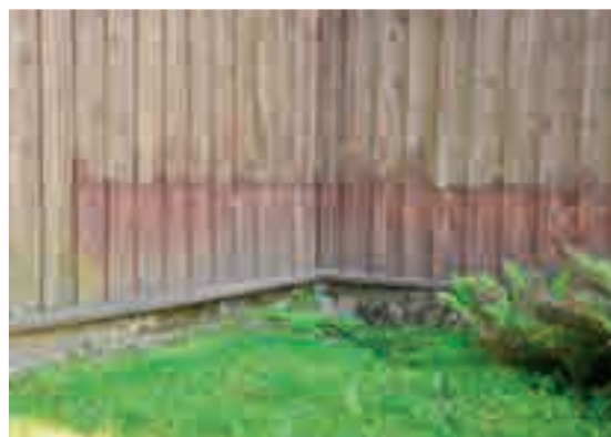
Fig. 6 - Sostituzioni delle tavole del rivestimento esterno.
