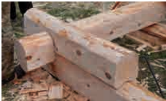
1.35, 1.36 - Il tronco viene sovrapposto ed inserito nell'alloggiamento predisposto sul tronco inferiore. L'incastro è completo. L'operazione si ripete per tutta l'altezza desiderata dei setti verticali. Questo tipo di costruzione si realizza direttamente sul luogo dove la stessa deve essere messa in opera. Nel caso di tronchi totalmente danneggiati, la struttura dell'edificio viene sollevata, affinché gli stessi possano essere sostituiti.
