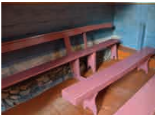
Fig. 2 - Dettaglio delle fondazioni, vista interna.
