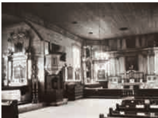
Fig. 9 - Interno della chiesa (1938). [46]
