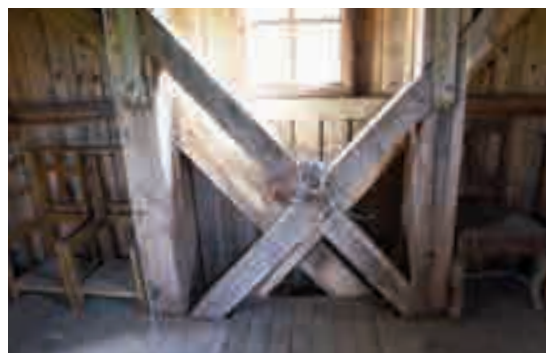
Fig. 15 - Unione fra i controventamenti.
