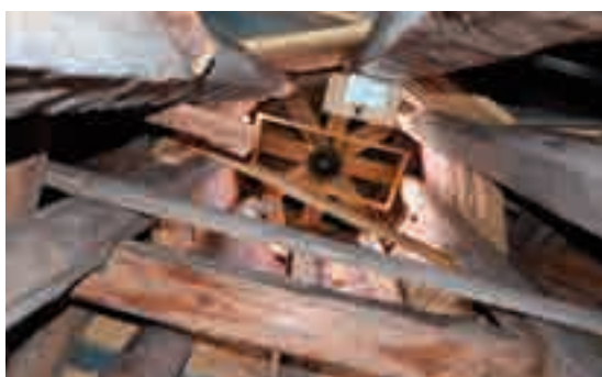
7.1.d - Irrigidimento orizzontale in legno della torre mediante l'impiego di tronchi. Questo intervento può essere accettabile, perchè è efficace e poco invasivo.
