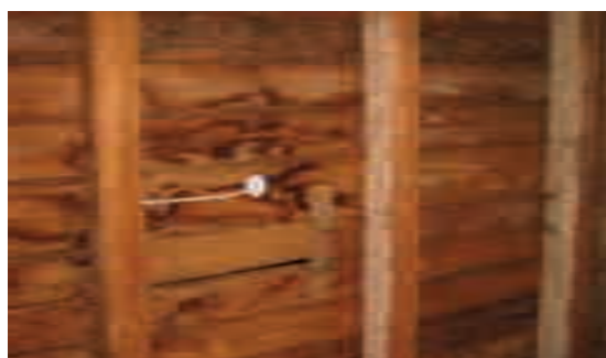
Figg. 10, 11 - L'umidità può causare il distacco dell'intonaco nei soffitti. Anche l'acqua che si accumula nei sottotetti danneggia le tavole lignee.
