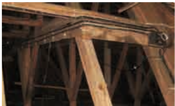
Figg. 26, 27 - Impianti elettrici chiodati direttamente alle strutture lignee della copertura senza protezione.
