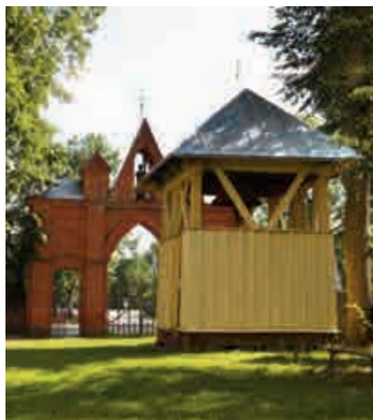
Fig. 13 - Nel primo piano il campanile realizzato con il sistema a telaio, nel secondo piano il cancello principale realizzato con i mattoni rossi.
