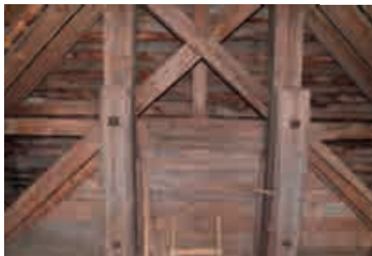
Fig. 7 - Sistema delle incavallature.
