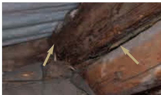
4.1.a,b - A sinistra: distacco fra gli elementi longitudinali rinforzato tramite un'altro elemento ligneo e cerchiature metalliche; a destra: attacchi fungini ed insetti dovuti alla umidità e l'acqua piovana. Bisogna procedere con una buona aerazione del sottotetto, la piallatura delle parti ammalorate e successivo trattamento con prodotti fungicidi.
