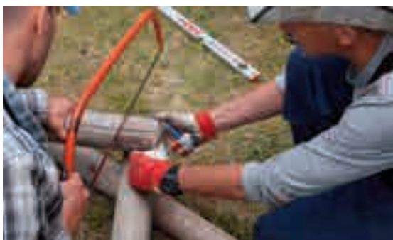
2.6, 2.7 - In questo caso si prepara un incastro a dente. Con la sega si taglia la linea segnata, mentre con l'ascia si spacca il legno preparando "un dente".
