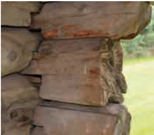
Figg. 3,4 - Esempi del sistema costruttivo con tronchi a sezione circolare; giunti sopra e sotto e scanalatura inferiore.
