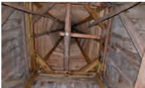
1.1. a,b - Ricostruzione della parte sommitale della torre dopo l'incendio avvenuto durante la Seconda Guerra Mondiale. Le nuove connessioni non sono state realizzate secondo i metodi tradizionali.
