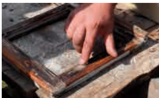
3.11, 3.12 - Dopo aver rimosso la polvere e la segatura dal telaio, su di esso viene applicato olio di lino, riscaldato a 60 gradi, o olio di lino mescolato con aceto. Questa operazione viene ripetuta preferibilmente finché il telaio non si è completamente impregnato del liquido. Il telaio deve poi asciugare per tre giorni. I fori nel telaio vengono riempiti con Kitas (miscela di gesso e olio di lino).
