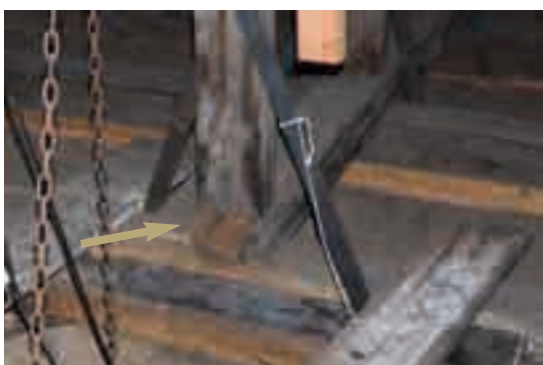
6.3.b - Deterioramento del materiale a causa di infestazioni di insetti. Bisogna procedere con l'eliminazione delle parti degradate e successivamente procedendo con l'installazione di una protesi di resina epossidica.
