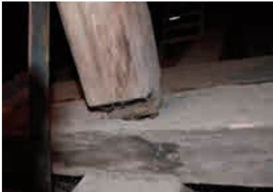
Figg. 32, 33 - A sinistra: sconnessione fra monaco e catena; a destra: affrancamento del chiodo ligneo.
