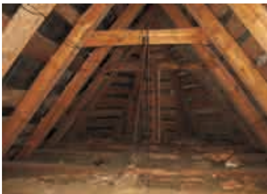
Fig. 9 - Struttura della copertura sopra abside.
