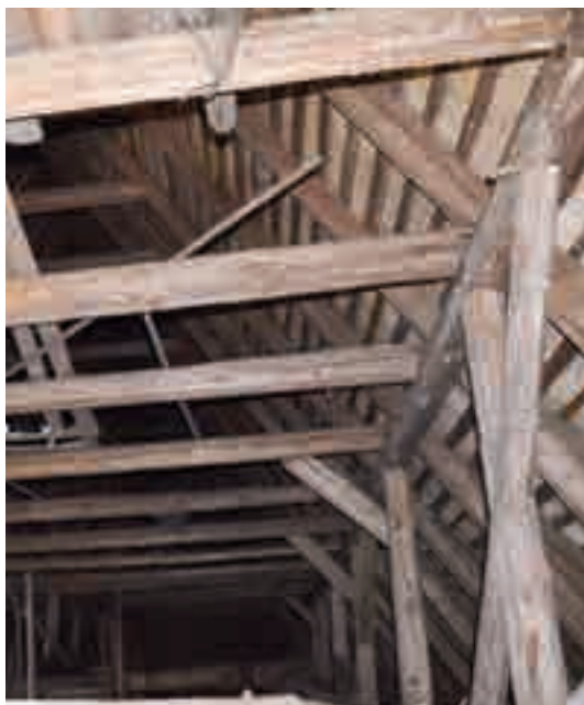
Fig. 10 - Struttura della copertura.
