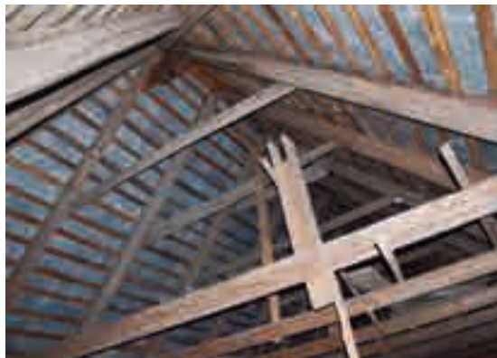
Fig. 8 - Struttura della copertura.
