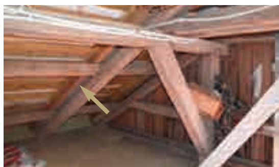
8.1.f - Sostituzione di un puntone.
