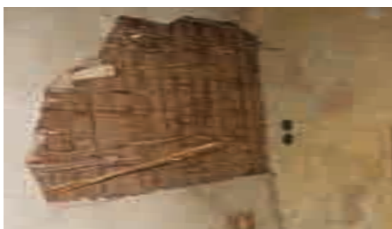
Figg. 10, 11 - L'umidità può causare il distacco dell'intonaco nei soffitti. Anche l'acqua che si accumula nei sottotetti danneggia le tavole lignee.
