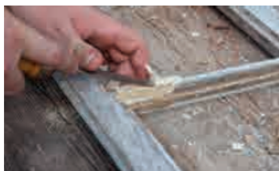
3.17, 3.18 - Adattamento degli inserti lignei al telaio tramite scalpelli e piccole lime/pialle.
