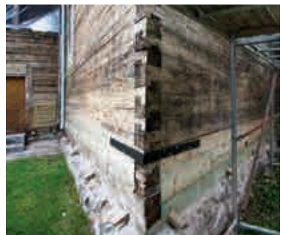
Figg. 7,8 - Foto di dettaglio del sistema costruttivo con giunto a dentatura; vista dall'interno e dall'esterno.
