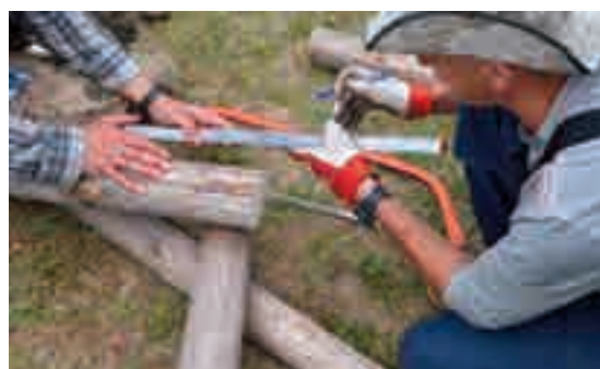
2.5 - A sinistra: a terra si segna la distanza tra i setti verticali, in questi punti vengono incassati i puntelli e si prova ad inserire i puntoni preparati con un angolo adeguato; a destra: quando l'angolo è determinato, successivamente vengono segnate le linee di taglio.
