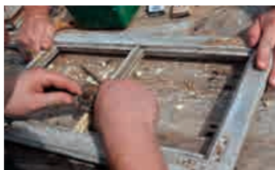
3.17, 3.18 - Adattamento degli inserti lignei al telaio tramite scalpelli e piccole lime/pialle.
