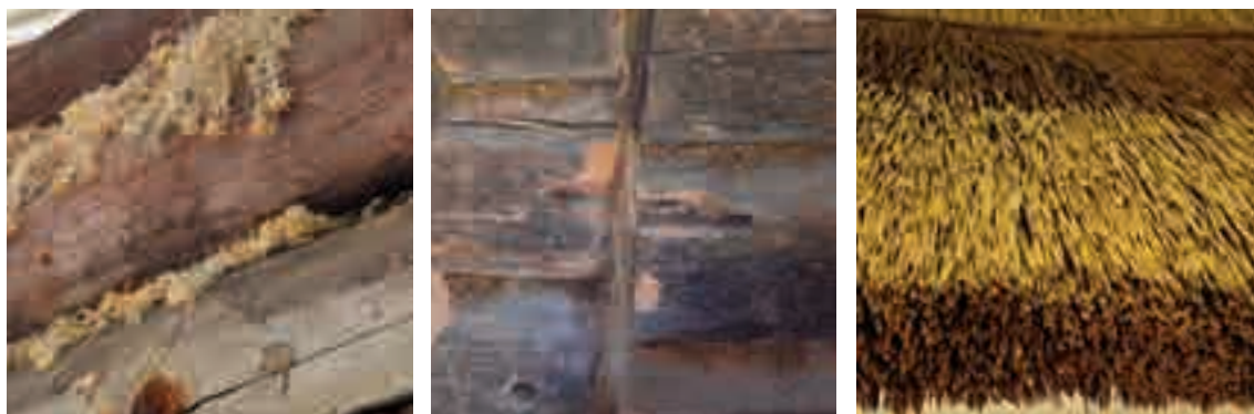
Fig. 3 - Muschio secco e stoppa di lino utilizzato per garantire isolamento termico fra i tronchi, paglia per rivestimento della copertura.
