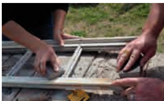
3.9, 3.10 - La rimozione della vecchia vernice dal telaio viene effettuata mediante raschietti e carta vetrata. Tale rimozione dello strato di pittura va eseguita senza danneggiare il legno, dopodiché il telaio viene accuratamente carteggiato.
