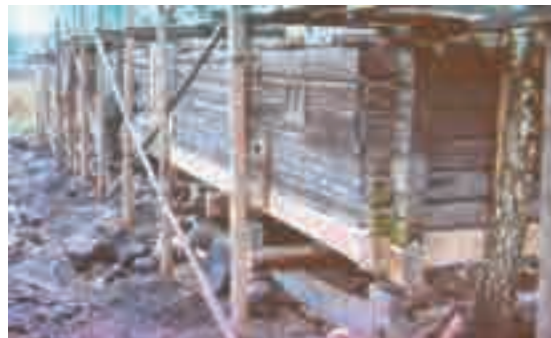
1.35, 1.36 - Il tronco viene sovrapposto ed inserito nell'alloggiamento predisposto sul tronco inferiore. L'incastro è completo. L'operazione si ripete per tutta l'altezza desiderata dei setti verticali. Questo tipo di costruzione si realizza direttamente sul luogo dove la stessa deve essere messa in opera. Nel caso di tronchi totalmente danneggiati, la struttura dell'edificio viene sollevata, affinché gli stessi possano essere sostituiti.
