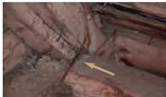
5.1.c - Rinforzo metallico tra monaco e catena. Questo tipo di consolidamento non è efficace ed anche errato, la grappa metallica ha provocato la rottura della fibratura del legno, è sempre meglio procedere con delle cerchiature (vedasi Fig. 41).
