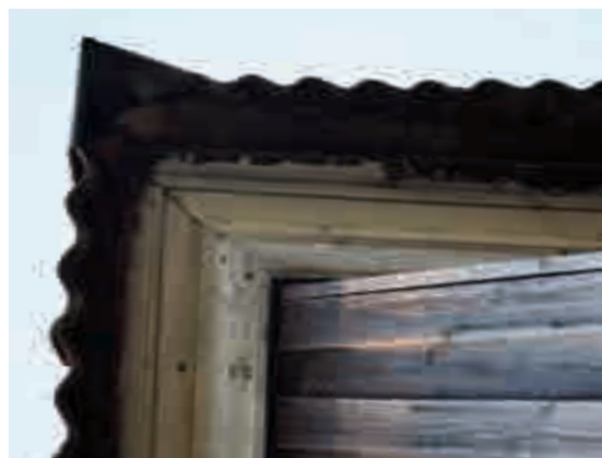
Fig. 5 - Dettaglio del cornicione.
