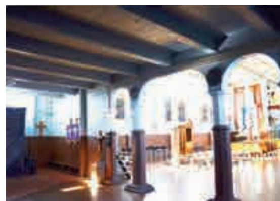
Fig. 6 - Costruzione della balconata interna.
