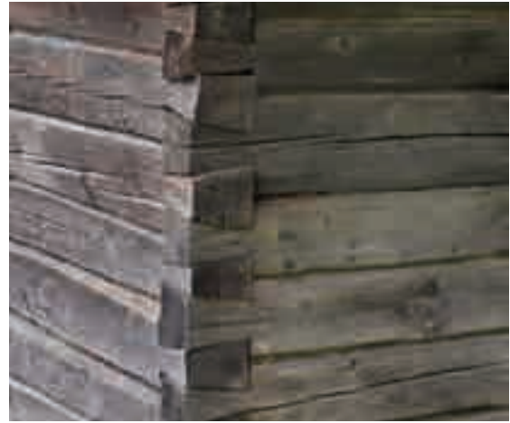
Figg. 3,4 - Foto di dettaglio del sistema costruttivo con incastri a coda di rondine; le viste dall'esterno.
