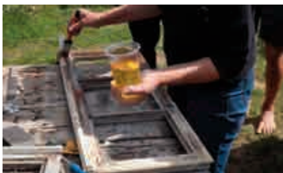
3.11, 3.12 - Dopo aver rimosso la polvere e la segatura dal telaio, su di esso viene applicato olio di lino, riscaldato a 60 gradi, o olio di lino mescolato con aceto. Questa operazione viene ripetuta preferibilmente finché il telaio non si è completamente impregnato del liquido. Il telaio deve poi asciugare per tre giorni. I fori nel telaio vengono riempiti con Kitas (miscela di gesso e olio di lino).
