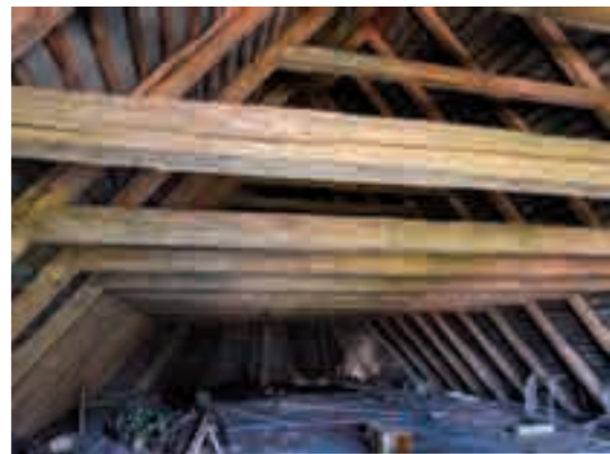
Fig. 10 - Struttura della copertura.
