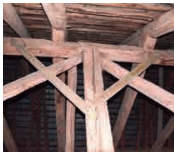
Fig. 9 - Struttura dei elementi longitudinali.
