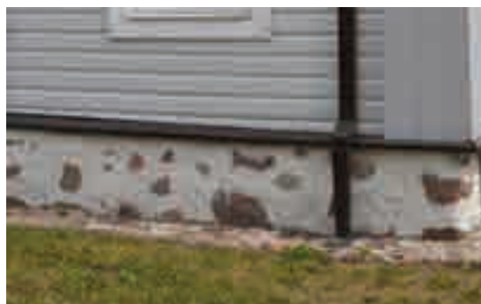
Fig. 2 - Fondazioni in pietra di varie dimensioni.
