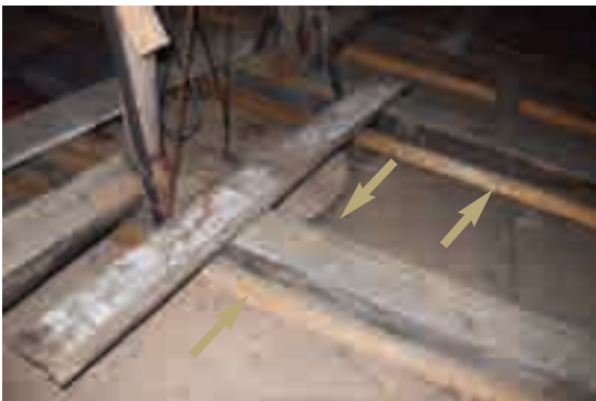
6.4.b - Rinforzo della catena mediante l'accostamento di nuove travi in legno. Intervento efficace e facilmente riconoscibile.
