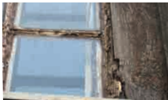
Figg. 6, 7 - A sinistra: il degrado del rivestimento esterno, dovuto alla umidità e l'acqua piovana, ha causato gravi danni ai setti verticali lignei; a destra: la mancanza di manutenzione degli infissi può portare danni ai setti verticali, dovuti alle intemperie e all'umidità.
