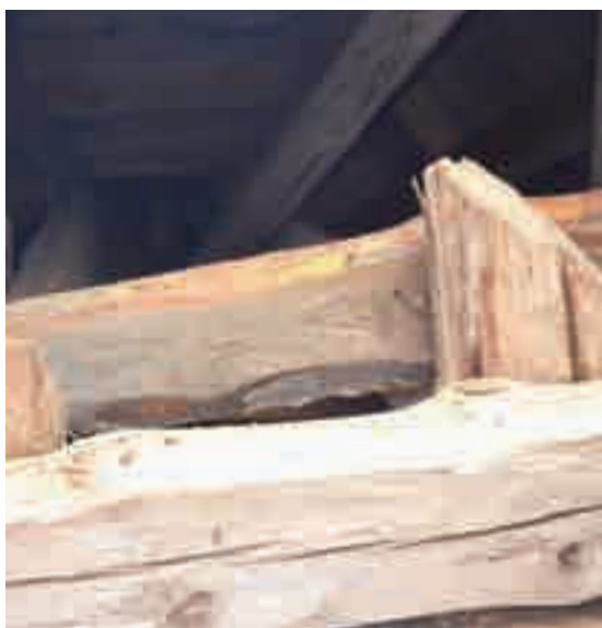
Figg. 51, 52 - A sinistra: tavola in legno scortecciata male e posizionata nel sottotetto durante i lavori di manutenzione; a destra: gli insetti della tavola scortecciata male si sono diffusi in altre strutture nel sottotetto.
