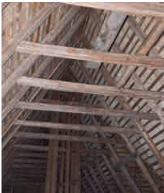
Fig. 7 - Struttura della copertura con vista della torre.
