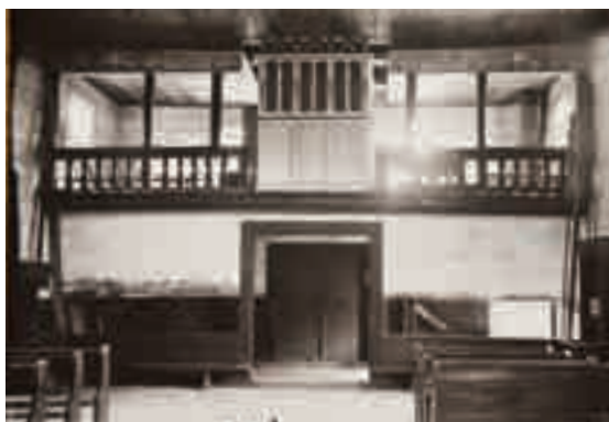
Fig. 8 - Balconata interna della chiesa (1938). [45]
