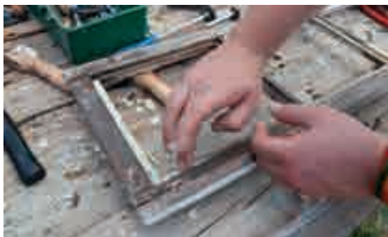
3.23, 3.24 - Quando si asciuga tale liquido a base di escrementi, si applica la miscela di Kitas (miscela di gesso e olio di lino). nelle parti che compongono l'alloggiamento del vetro.
