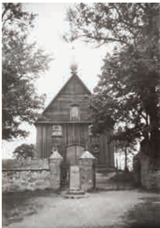
Fig. 4 - Vecchio rivestimento della chiesa. [30]
