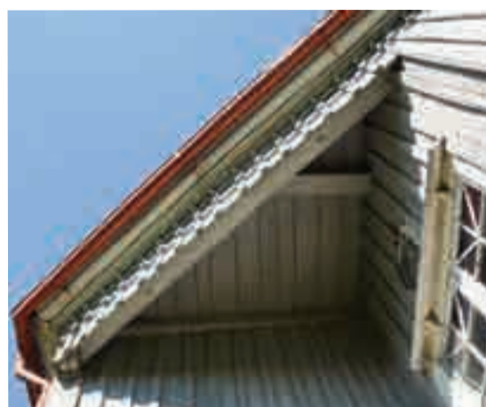
Fig. 6 - Dettaglio del cornicione.
