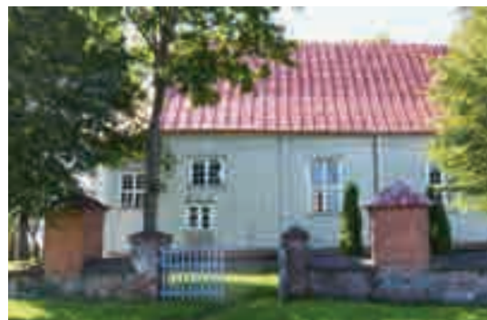
Fig. 4 - Recinzione con il cancello e stazioni Via Crucis.
