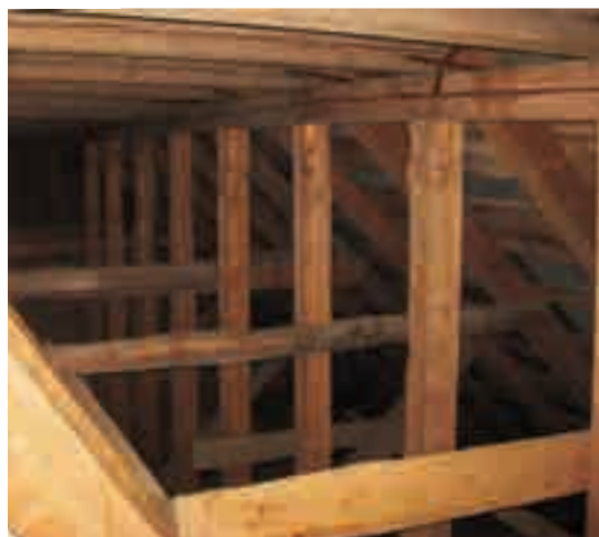
Fig. 8 - Sistema delle incavallature.
