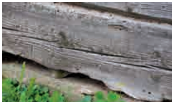
Figg. 4, 5 - A sinistra: i tronchi con funzione di architrave e di davanzale, che costituiscono la parte terminale della struttura, sono soggetti ad essere maggiormente esposti alle intemperie; a destra: gli agenti atmosferici, come il sole e l'acqua, possono danneggiare i tronchi a contatto diretto con le fondazioni. Infatti questi tronchi vanno spesso sostituiti.
