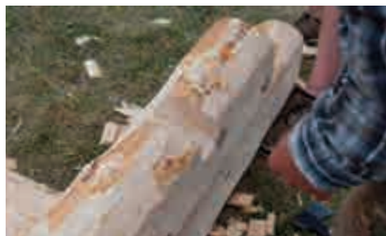
2.3 - Preparazione di un incavo dei puntoni; 2.4 - Preparazione di un alloggiamento per i puntoni nei setti verticali.
