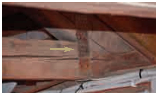
8.1.c,d - Inserimento di placche metalliche di rinforzo fra due puntoni e fra puntone e sottocaten. La fascia metallica si oppone al naturale ritiro, infatti ha provocato la fessurazione delle membrature.
