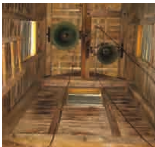
Fig. 12 - Vista interna del campanile.
