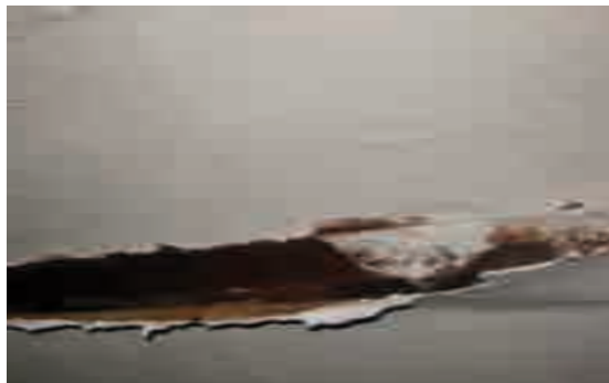
Figg. 12, 13 - La prima conseguenza di attacco da parte di funghi, l'alterazione del colore naturale del materiale. In questo esempio intonaco ed verniciatura distaccata dai setti verticali lignei a causa di emergenza di funghi.
