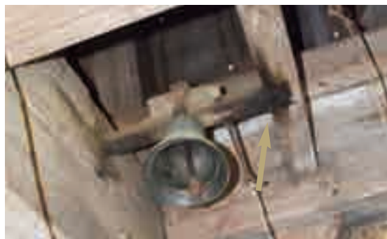
1.1. c,d - Danni alla struttura lignea a sostegno delle campane a seguito dell'inserimento di grandi staffe metalliche.
