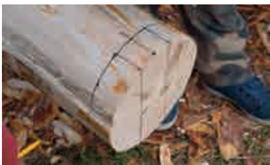
1.9, 1.10 - Il tronco così lavorato è pronto per essere inciso: si segnano le opportune linee di taglio e si procede a creare due incavi opposti nell'estremità del tronco; il tocco di legno rimanente fra di essi si chiama dente. Le dimensioni di un dente sono di circa 6 cm di lunghezza e 8 cm di spessore.
