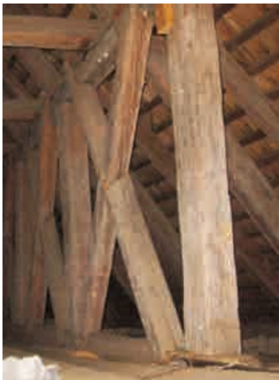
Fig. 8 - Sistema di rinforzo longitudinale.
