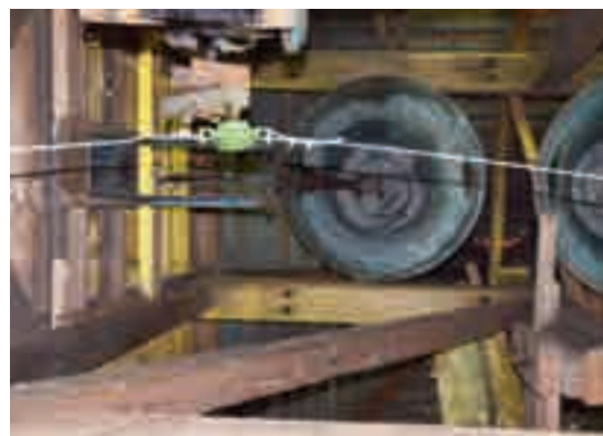
Fig. 13 - Struttura portante della campana.
