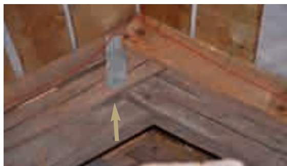
8.1.c,d - Inserimento di placche metalliche di rinforzo fra due puntoni e fra puntone e sottocaten. La fascia metallica si oppone al naturale ritiro, infatti ha provocato la fessurazione delle membrature.
