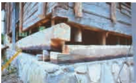
1.37, 1.38 - Alcuni esempi di lavoro di sostituzione dei tronchi inferiori.
