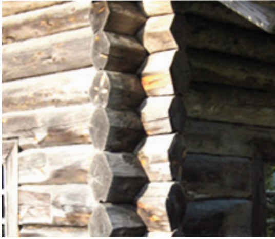
Figg. 1,2 - Esempi del sistema costruttivo con tronchi a sezione esagonale.
