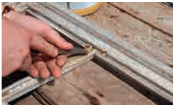
3.7, 3.8 - Con scalpelli e seghe sono rimosse le parti danneggiate a contatto con il telaio ligneo.
