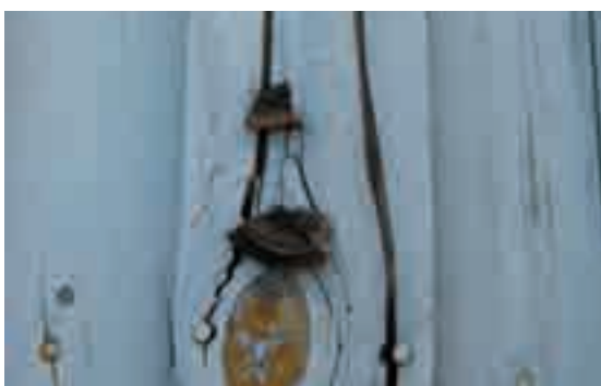
Figg. 18, 19 - A sinistra: riduzione del volume dello stipite a causa della penetrazione diretta dell'acqua; a destra: la presenza di eumiceti nelle tavole in legno del rivestimento esterno.
