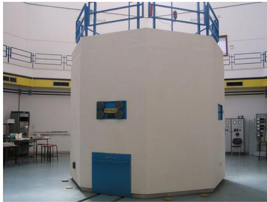
Figura 4.6: Reattore nucleare di ricerca AGN-201 Costanza in dotazione al Dipartimento Energia, Ingegneria dell'Informazione e Modelli Matematici (DEIM) dell'Università di Palermo.
