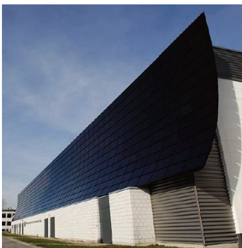
Photo 15 - Sulfurcell CIGS modules integrated on the façade of Ferdinand-Braun-Institut für Höchstfrequenztechnik, Berlin, 2011
