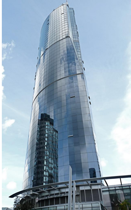
Fig. 2.8 – The One Wall Centre (Vancouver, Canada).
