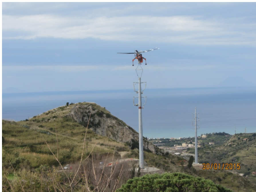
Figura 20. Montaggio di sostegni tubolari
