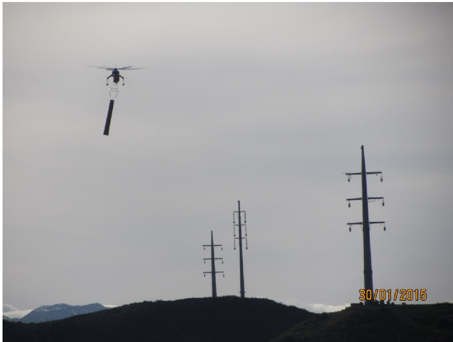
Figura 19. Trasporto di sostegni tubolari
