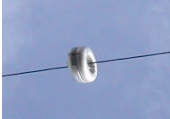
Figura 22. Donut installato su un conduttore di fase
