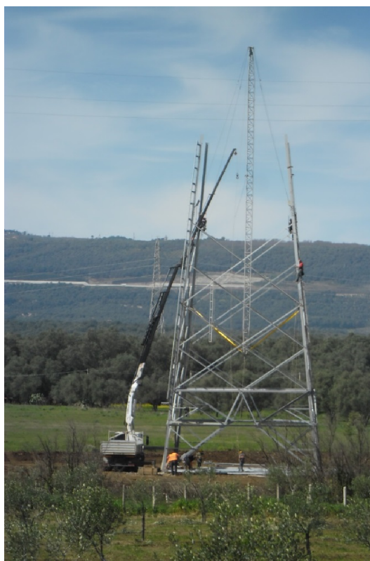
Figura 18. Montaggio di un traliccio attraverso l'uso del falcone
